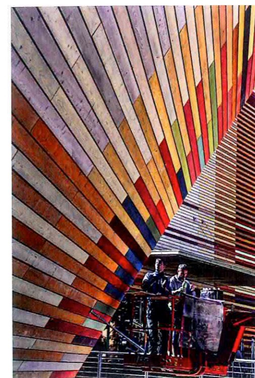
Auditorium del Parco a L'Aquila. Foto durante l'esecuzione del cantiere. La costruzione completamente in legno fornito dalla provincia di Trento, esclusa la soletta di fondazione in c.a., è pensata per essere smontabile nel caso la si volesse collocare altrove
