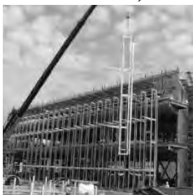
Messa in opera della struttura di supporto
