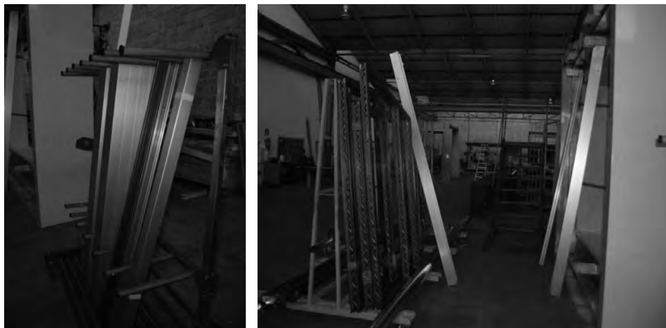
Fig. 5.10. Prototipo. Assemblaggio della struttura primaria in montanti e traversi della pelle interna e della pelle esterna
