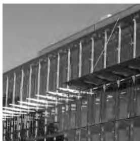
Installazione della pelle interna
