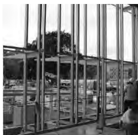
Struttura di supporto alla facciata vista interna
