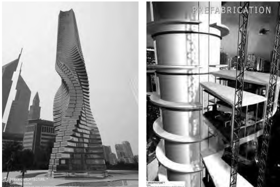
Fig. 2.12: Rotating Tower, David Fisher, 2006. Il progetto è caratterizzato dall'idea di rendere i vari piani indipendenti gli uni dagli altri e capaci di ruotare. Il core strutturale della torre è una turbina eolica
