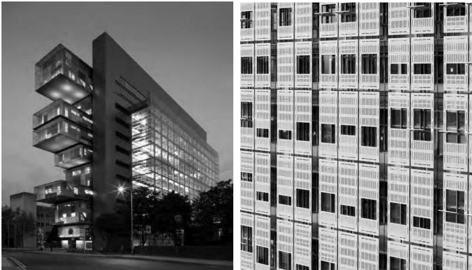
Fig. 1.2: Tribunale Civile Manchester, Denton Corker Marshal, Manchester, Regno Unito, 2003. Esempio di involucro eco efficiente o ambientalmente interattivo. La parte pubblica si distingue per la presenza di un doppio involucro vetrato contenente i volumi opachi sospesi delle sale d'attesa. Gli uffici sono contenuti in blocchi di vetro colorato schermati da un diaframma metallico.
