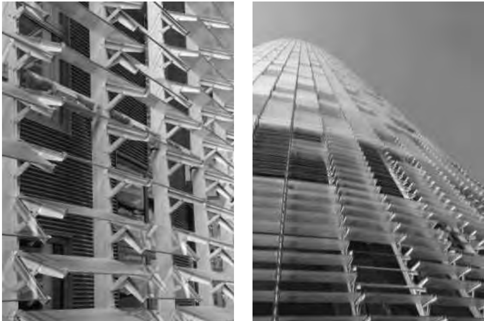
Fig. 3.15: Torre Agbar, Jean Nouvell, Barcellona, 2007. L'edificio è caratterizzato da un sistema di facciata doppia pelle in cui il layer esterno è stato realizzato come un brise-soleil in vetro con vari gradi di trasparenza. Il sistema a lamelle esterne regolabili garantisce la ventilazione naturale nell'intercapedine soprattutto nei mesi estivi quando la temperatura esterna è molto elevata.
