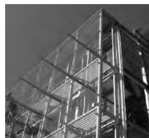
Messa in opera della seconda pelle
