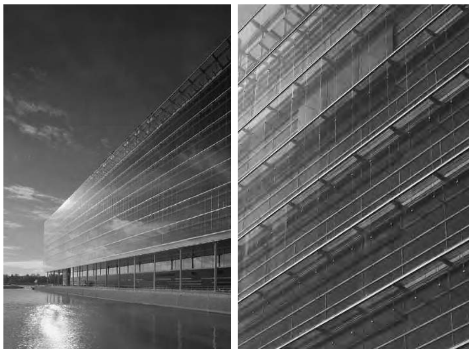
Fig. 2.19: Radiolinja Office Building, Tommila Aarchitects Ltd, Keilasatama Espoo, Finlandia, 2001. La facciata doppia pelle è collegata con il sistema di condizionamento, e funziona come un sistema di preriscaldamento dell'aria nei mesi invernali e nelle stagioni intermedie, contribuendo a ridurre il fabbisogno energetico dell'edificio. In estate l'aria calda dell'intercapedine è estratta all'esterno dalle bocchette collocate sulla parte alta della superficie vetrata. La pelle interna è realizzata con infissi a triplo vetro, mentre la pelle esterna è costituita da un vetro stratificato di 10,00 mm. L'intercapedine misura 60,00 cm ed è scandita da passerelle in acciaio forato che vengono utilizzate per la manutenzione del sistema di involucro. All'interno della buffer zone è collocato un sistema schermante costituito da una tenda a lamelle, tipo greisser, la cui apertura è regolata da un sistema informatico in relazione alle condizioni di irraggiamento esterno.
