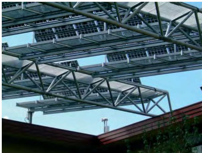
Fig. 17 - Particolare dei frangisole fotovoltaici
