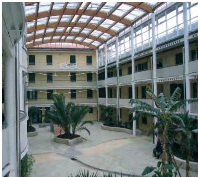
Fig.1,2 Quartiere Savonarola a Padova- Serra - Nell'ambito della riqualificazione del Quartiere Savonarola a Padova è stata realizzata una serra bioclimatica da utilizzarsi come giardino di inverno per appartamenti a ballatoio. Progetto realizzato nel 2003. Questa soluzione, applicata per la prima volta nel clima Italiano, è stata verificata e monitorata sia in estate che in inverno, rispondendo in maniera ottimale alle previsioni di progetto
