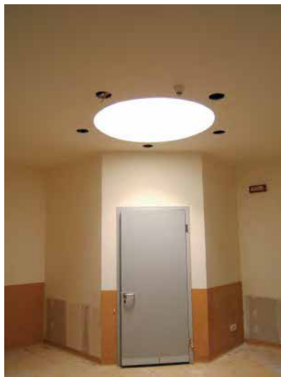
Fig. 14 - Condotti di luce, per l'illuminazione naturale, vista interna
