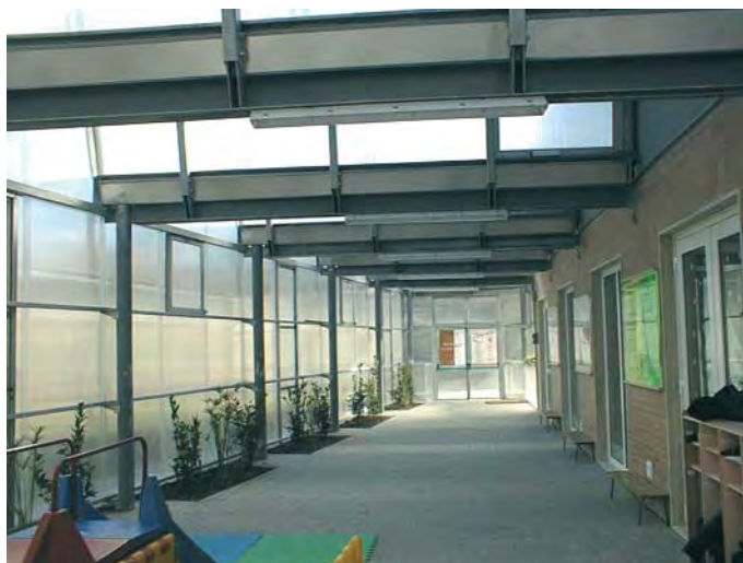
Fig. 9 - Vista interna della serra, collegamento tra la scuola elementare e la materna, spazio giochi
