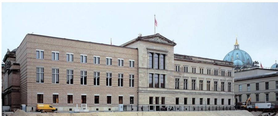
Fig. 11. Facciata ovest. Si percepisce con chiarezza la ricomposizione dell'ala distrutta, con semplificazione e rigore formale
