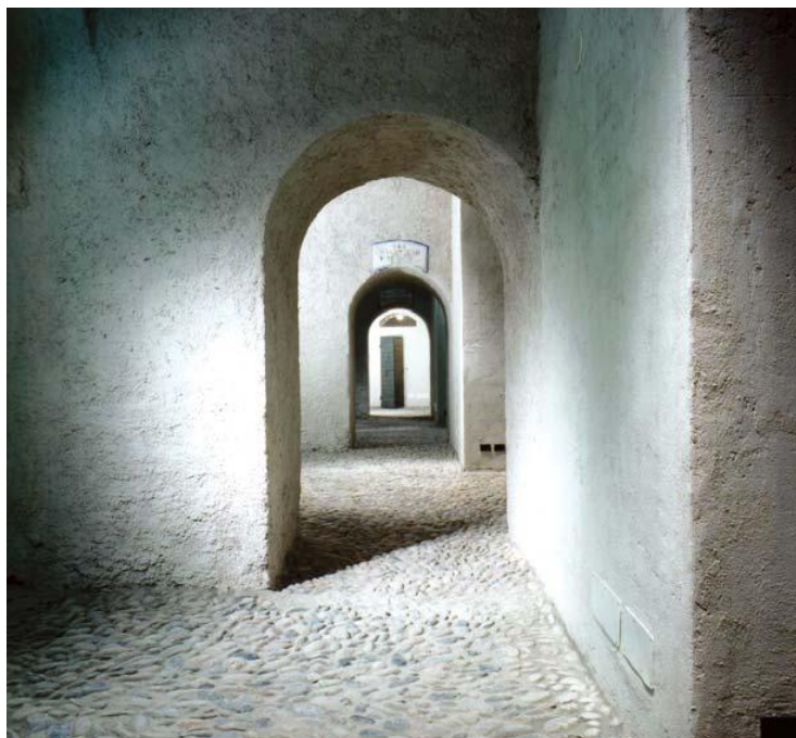
Fig. 11. Interno dell'Opera Carlo Alberto. I trattamenti sulle superfici mantengono l'atmosfera austera e sobria della fortezza. (tratta da: http://www.devitassociati.it/ )
