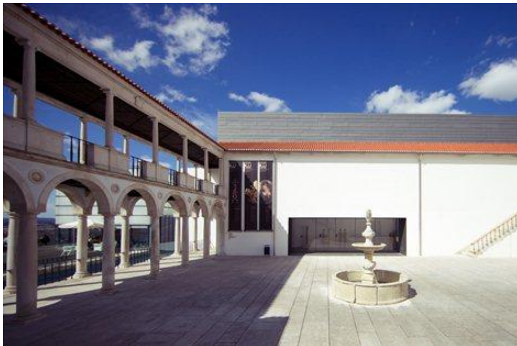
Fig. 32. Interno della corte: il completamento dell'unitarietà del complesso è affidato ad un linguaggio semplice e dichiaratamente contemporaneo.
