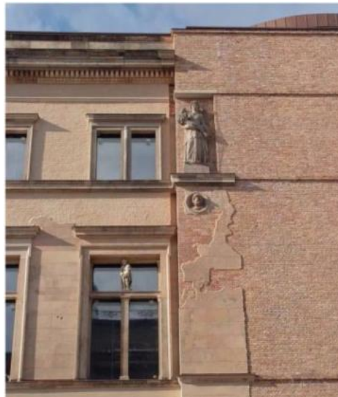
Fig. 12. Il paramento murario del prospetto ovest
