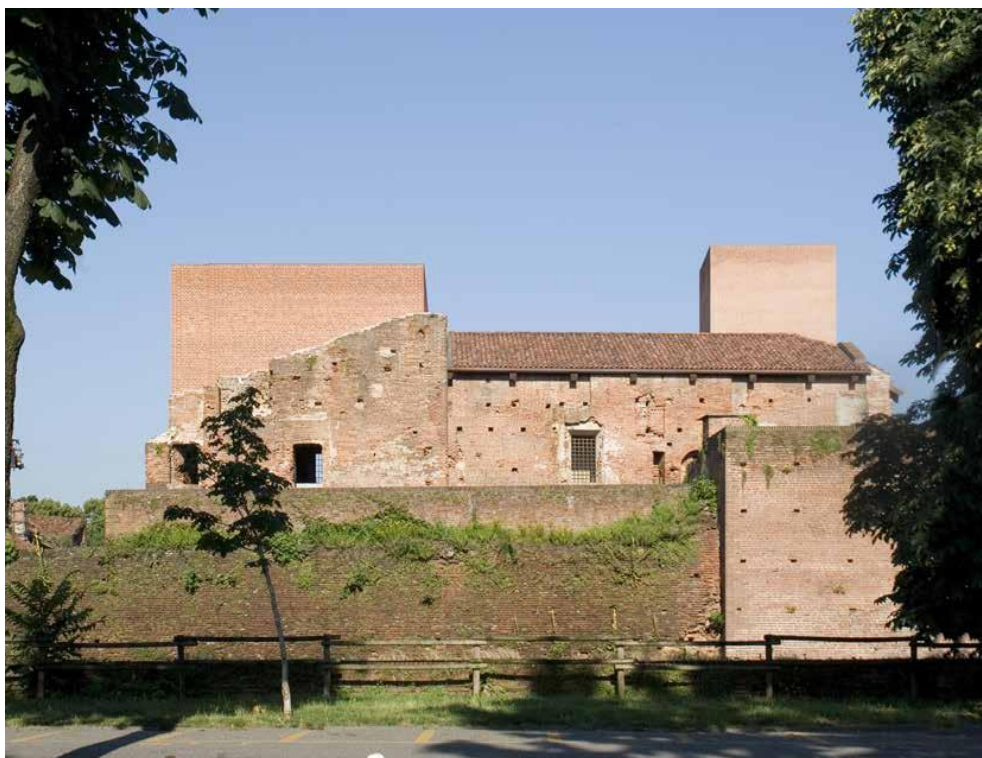
Fig. 40, 41. Il mattone padano ricompone l'unitarietà dei prospetti e delle volumetrie, raccordandosi alla materia esistente. (tratta da: http://www.zermaniassociati.it/opere/ )
