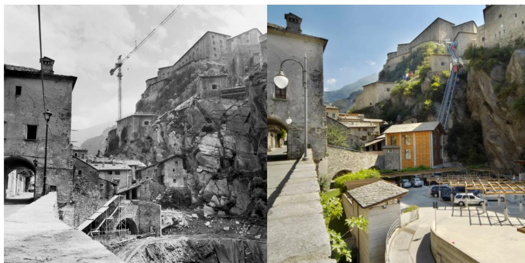
Fig. 8. La realizzazione dell'area del parcheggio a valle
