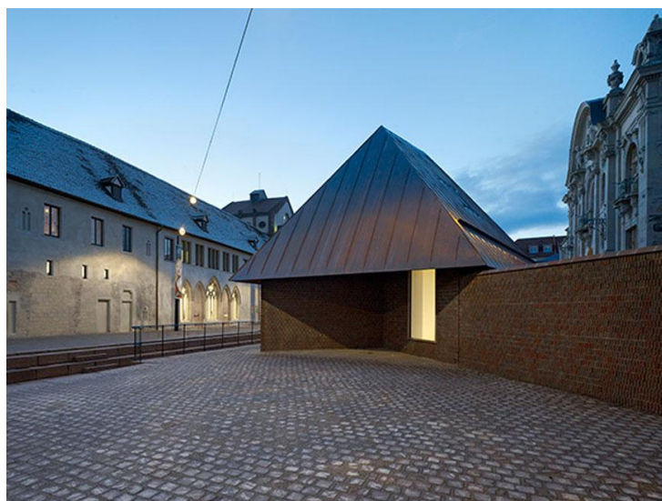
Fig. 14. Colmar, Musée Unterlinden. La piccola maison che costituisce il nuovo ingresso
