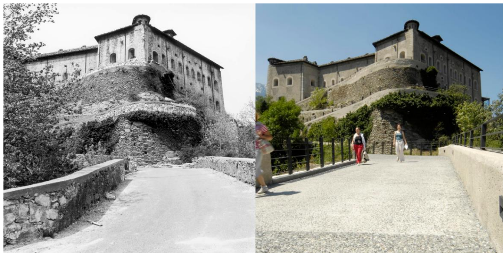
Fig. 7. Vista dell'accesso al Forte prima e dopo il restauro
