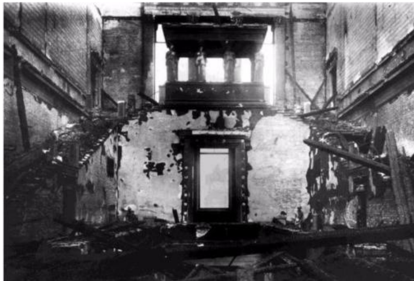
Fig. 4. Lo scalone monumentale danneggiato dai bombardamenti, 1943, C. Hofer
