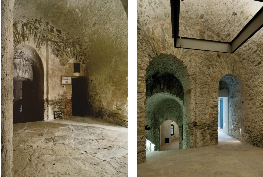
Fig. 13. Interno dell'Opera Ferdinando. Stato prima e dopo il restauro
