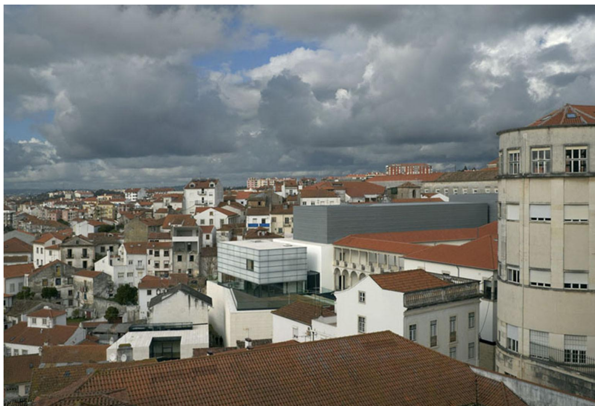
Fig. 31. Coimbra, Museo Machado de Castro. I nuovi volumi, dalle forme pure e regolari, si rapportano al contesto stratificato della città, alle sue altezze e volumetrie. (tratta da: "L'industria delle costruzioni", 446 (novembre-dicembre 2015), p. 64).
