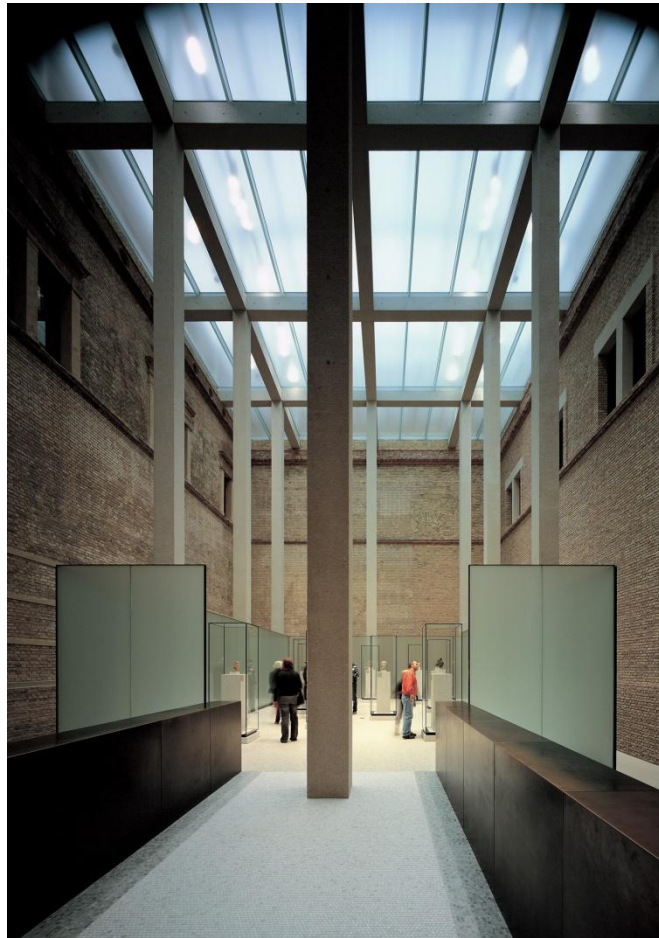
Fig. 23 e 24. Corte egizia, livello superiore e inferiore (24). L'inserimento del podio sorretto da esili pilastri in calcestruzzo nel vuoto della rovina permette di articolare il percorso espositivo (tratte da: "El Croquis," 150 (2010), pp. 56-57)
