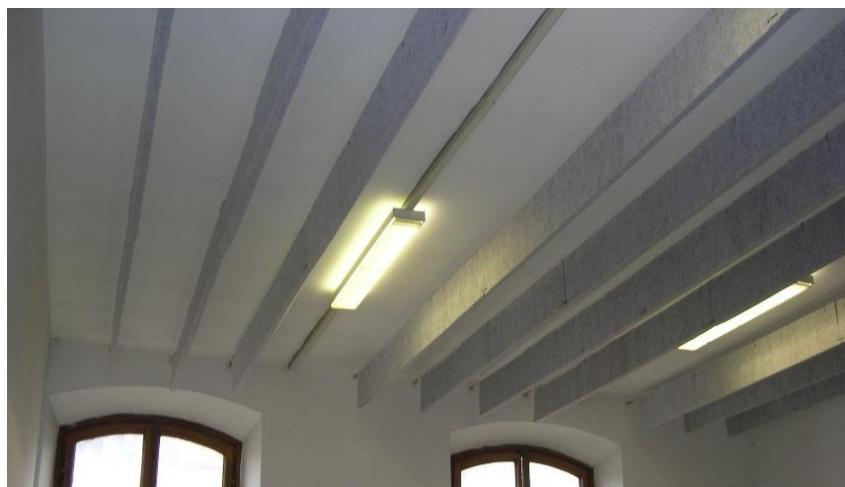
Figura 5 – Applicazione di pannelli in fibra di poliestere riciclato nella modalità “baffles”
