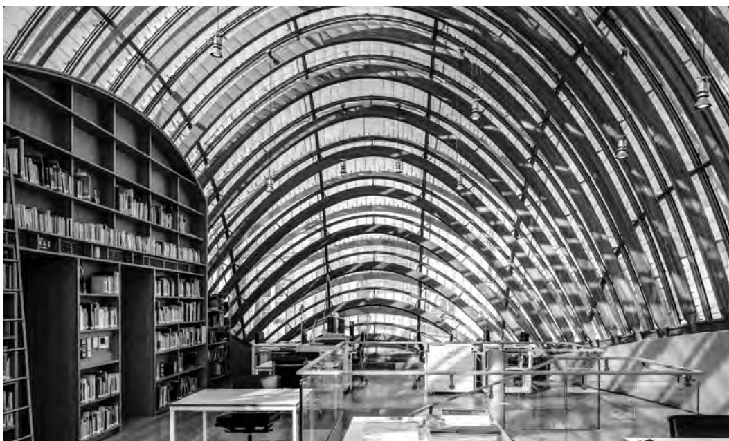
6/ Fondation Pathé. La copertura vetrata della sala riunioni all'ultimo piano (foto Paul Raftery).
