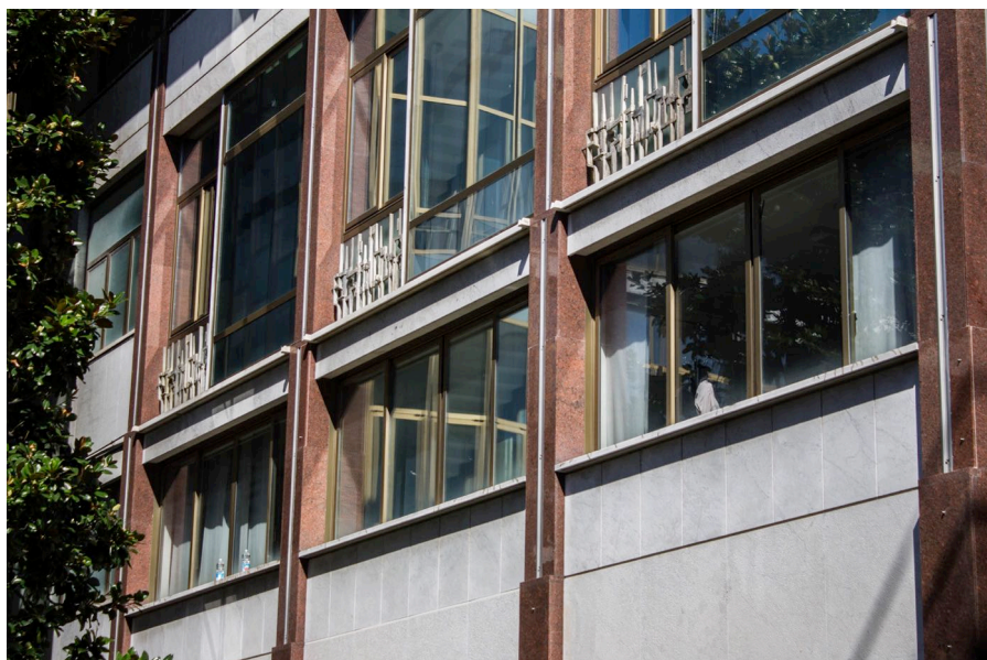
4. Carlo Aymonino, Camera di Commercio, Industria e Agricoltura di Carrara, fronte verso il giardino, particolare (foto dell'autore).
