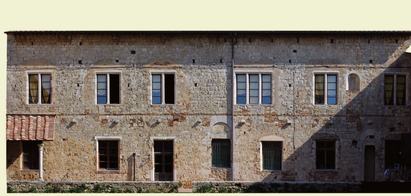
Fotoraddrizzamento del lato Nord
