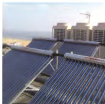
Fig. 477 Esempio di applicazione del solare termico con tubi sottovuoto
