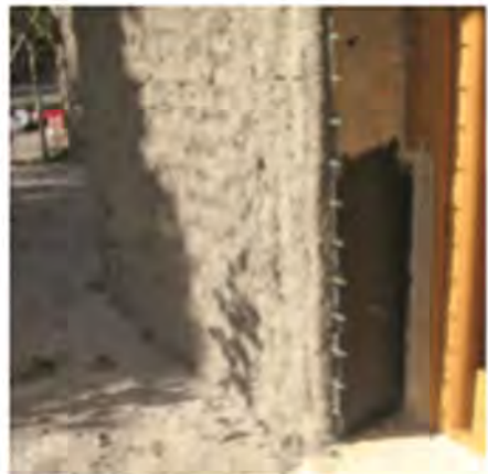
Fig. 455, 456 Dettaglio intonaco termoisolante
