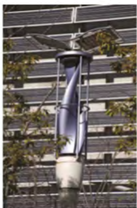
Fig. 483 Generatore eolico ad asse verticale
