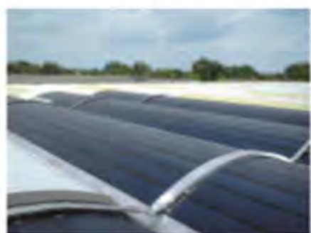
Fig. 465 Esempio di applicazione del film in silicio amorfo
