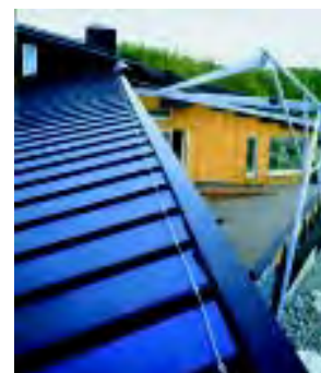
Copertura in metallo laminato realizzata da Rannila, Uni-solar
