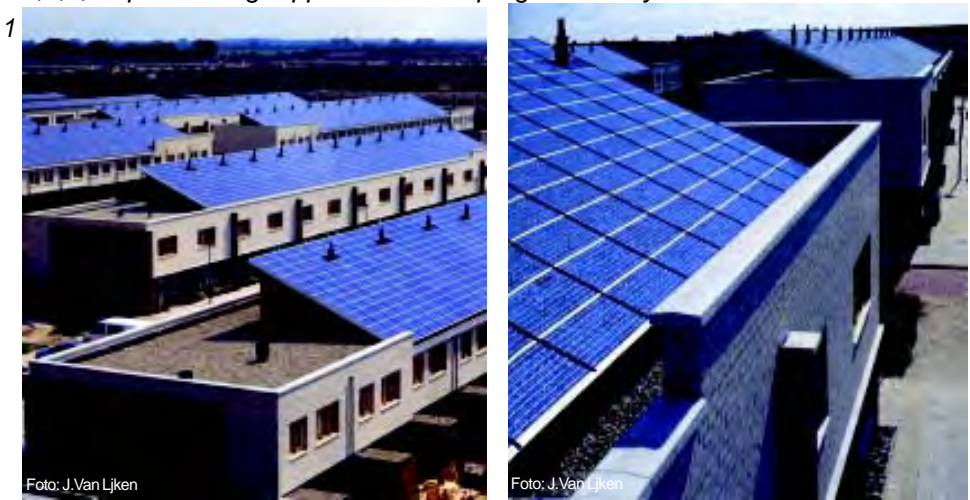
1,2,3, Coperture degli appartamenti del progetto Jersey
