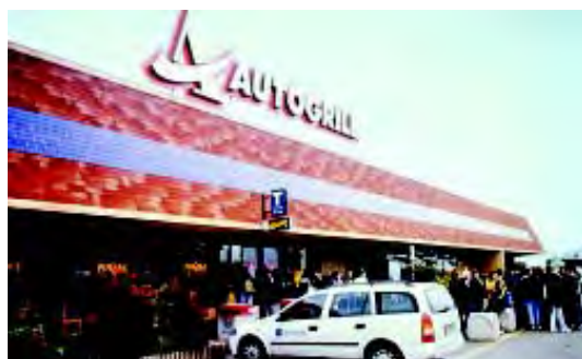
Fascia FV decorativa ad un Autogrill
