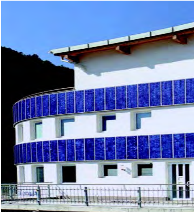
Integrazione fotovoltaica come elementi di rivestimento - BP solar
