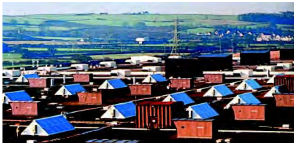
Vista aerea dell'installazione dei lucernari
