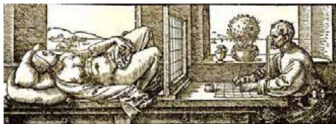
Fig. 9 – Ultima versione dello strumento per disegnare presentato da Dürer. L'occhio del pittore su un mirino traguarda il modello – una donna sdraiata sul medesimo tavolo dove egli disegna – attraverso un telaio prospettico con fili tesi (A. Dürer, Ueber die Kunst der Messung , Norimberga 1525).
