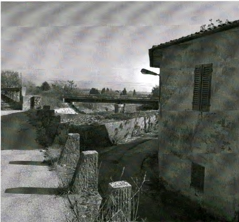
Figura 11: Il ponte di Squarciabocconi costruito in sostituzione dell’antica struttura di attraversamento distrutta.
