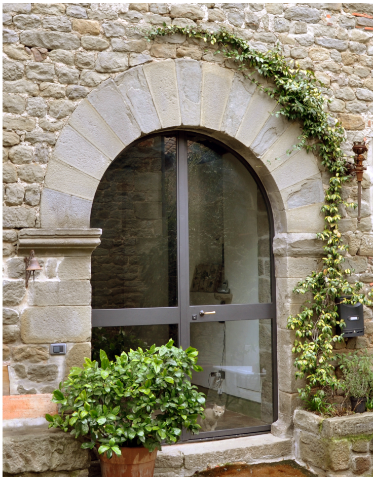
Fig. 2 - Particolare della mensola modanata dell'accesso principale
