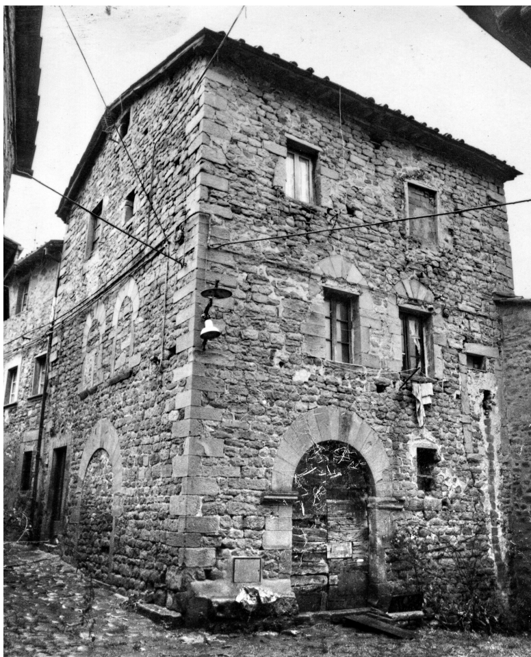
Fig. 1 - Il palazzo pubblico di Pietrabuona. Foto conservata all'archivio fotografico della Soprintendenza (Soprintendenza per i Beni Architettonici di Firenze, riproduzione fotografica n. 102351. Su gentile concessione del Ministero per i Beni e le Attività Culturali)
