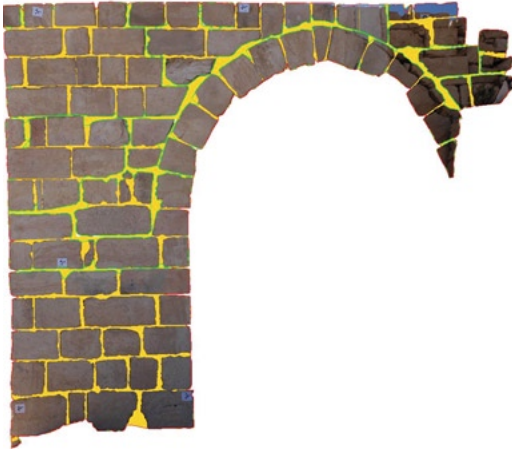
Fig. 6 – Orthophoto générée par une requête sur la base de données: visualisation des blocs appartenant aux USM visibles sur le plan de projection donné. En jaune l'extraction automatique du mortier, en vert le périmètre des USM. Voir Pl. XII, a.
