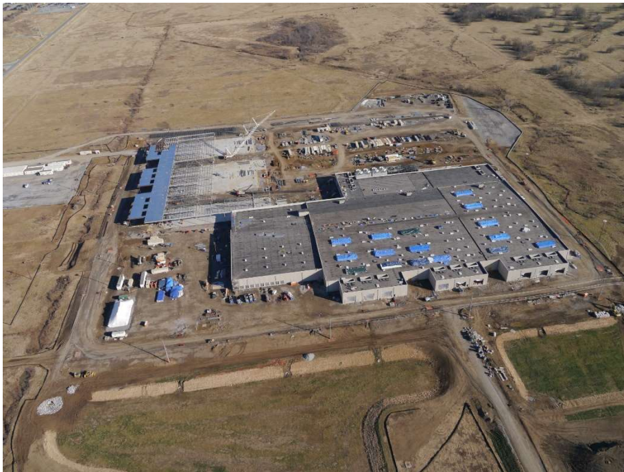
Fig. 3. Foto aerea del Google Data Center di Mayes County, Oklahoma
