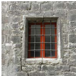
W.12 Via delle Cantine
