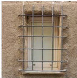
W.52 Via del Deposito
