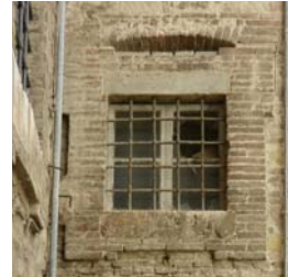
W.5 Via della Sinagoga
