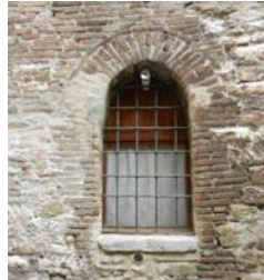
W.83 Via Benincasa
