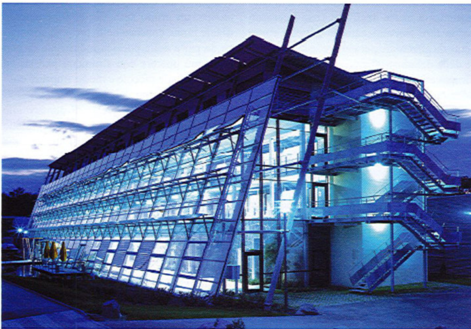
Fig. 1 - Edificio Solar Fabrik a Friburgo (DE)
