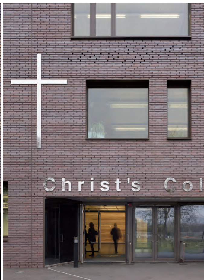
La tessitura in laterizio presenta dei «vuoti» per le entrate e le uscite dell'aria.
