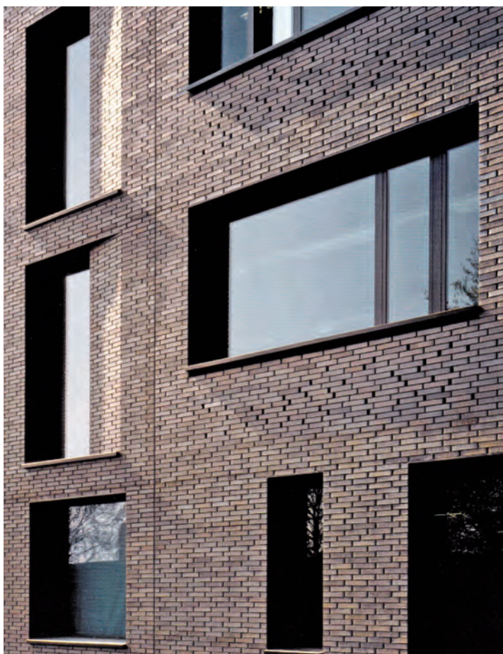
Dettaglio della facciata in mattoni pieni in laterizio faccia a vista.
