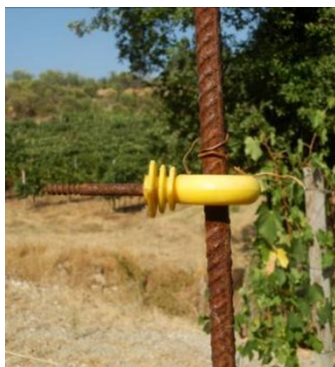
Fig. 8 Isolatore nato per essere avvitato su pali in legno, posizionato al contrario sul picchetto di metallo.
