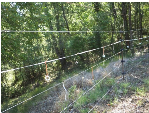
Fig. 30 Soluzione costruttiva con appendici verticali mobili.
