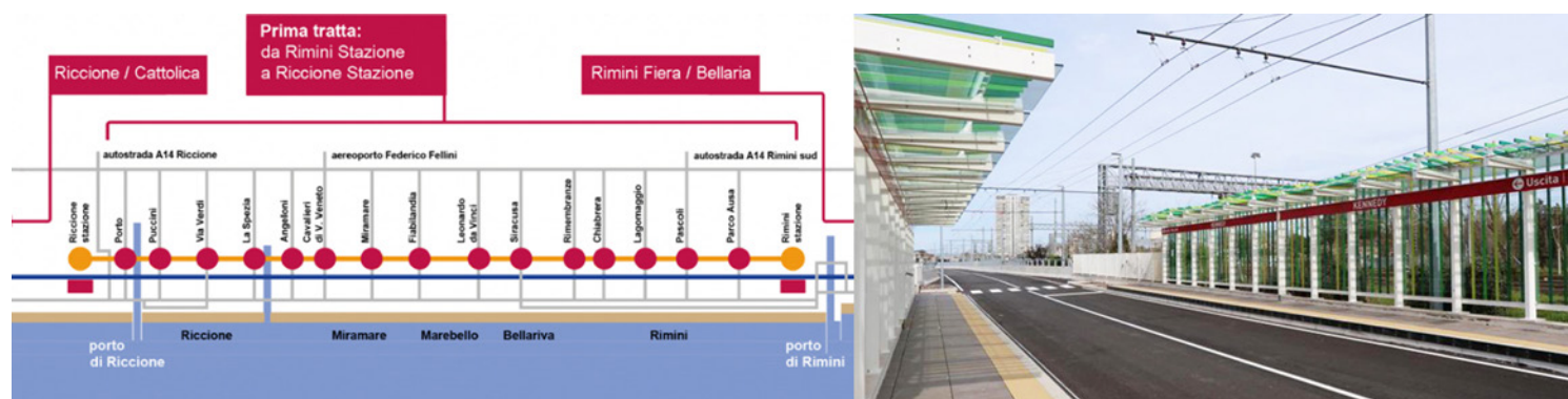
Fig. 11 - Tramvia costiero TRC in fase di ultimazione tra Rimini e Riccione.
