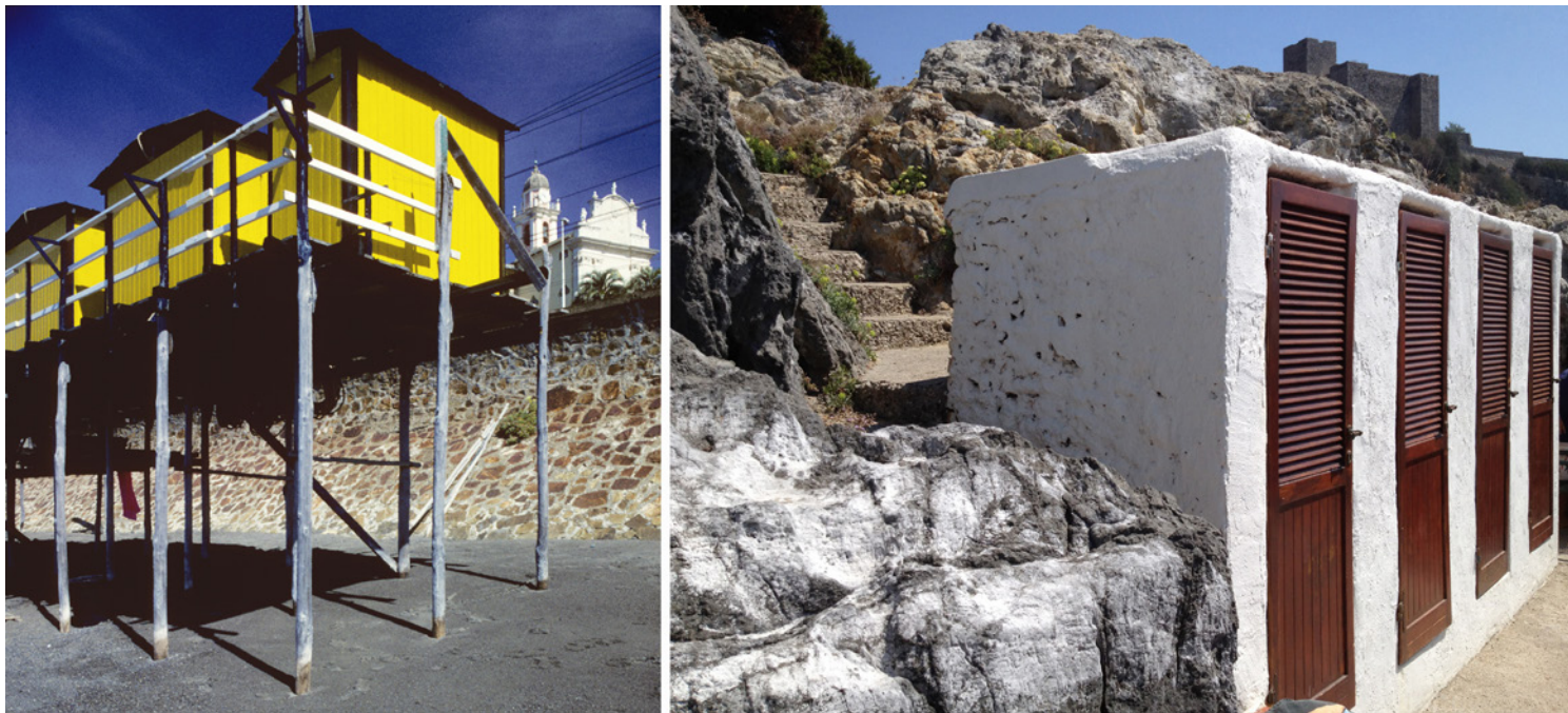
Fig. 4 - Stabilimenti balneari a Cavi di Lavagna (GE) e Talamone di Orbetello (GR).
