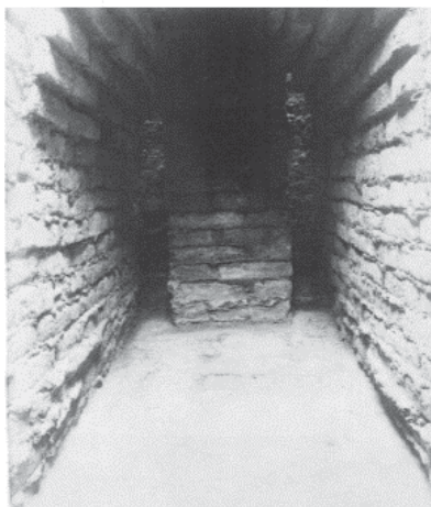
Figura 20. Interno della volta di C43: pilastro e fori di sfiato (Woolley, Mallowan 1976)
