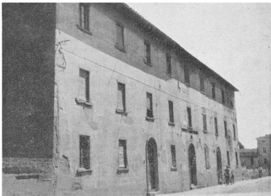
Vecchio edificio in via Livornese, prima sede dal 1899 al 1943 del Ricovero "Vincenzo Chiarugi"
