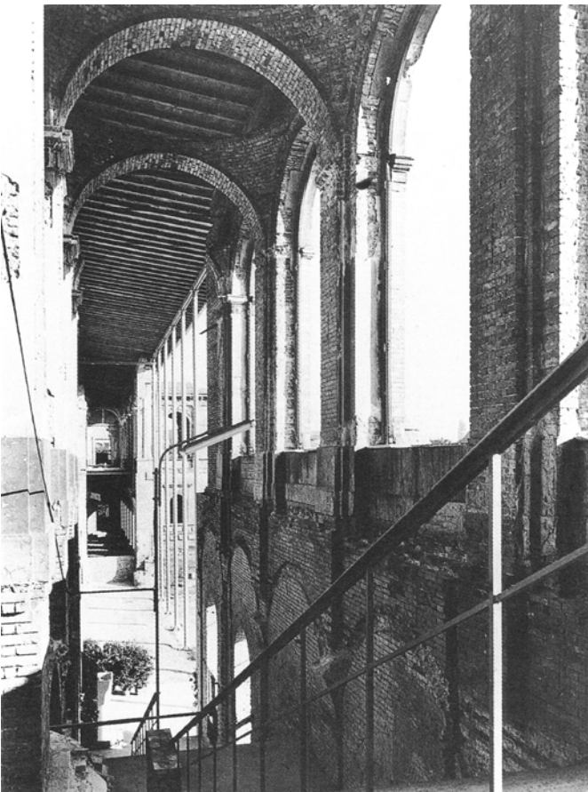
3.71. I lavori di ricostruzione della scala, [da: Altenhöfer, 1996].
