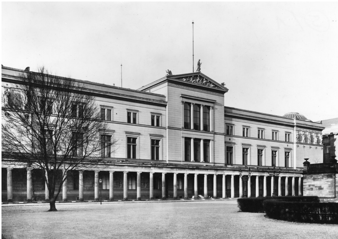
5.24. La facciata ovest, [SMzB].
