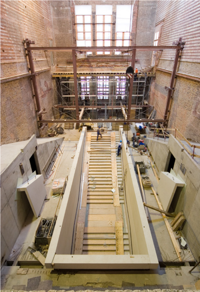
5.89. La scala nella fase di cantiere, [foto: Andrea Korth, DCAB].
