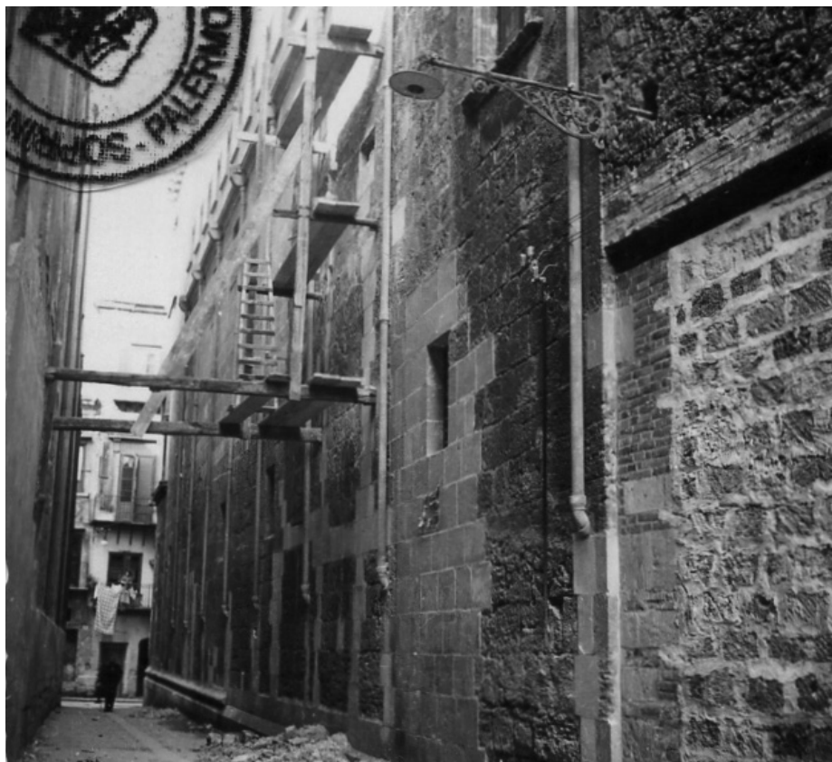
4.41. I lavori di ricostruzione sulla facciata di vicolo della Salvezza, [AFSMP, n. 166, 11.1952].
