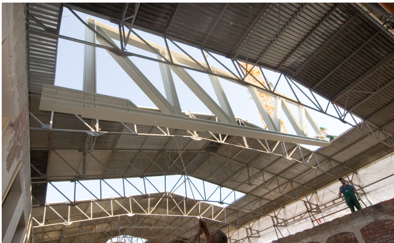
5.94. La copertura in fase di cantiere, [foto: Andrea Kroth, DCAB].
