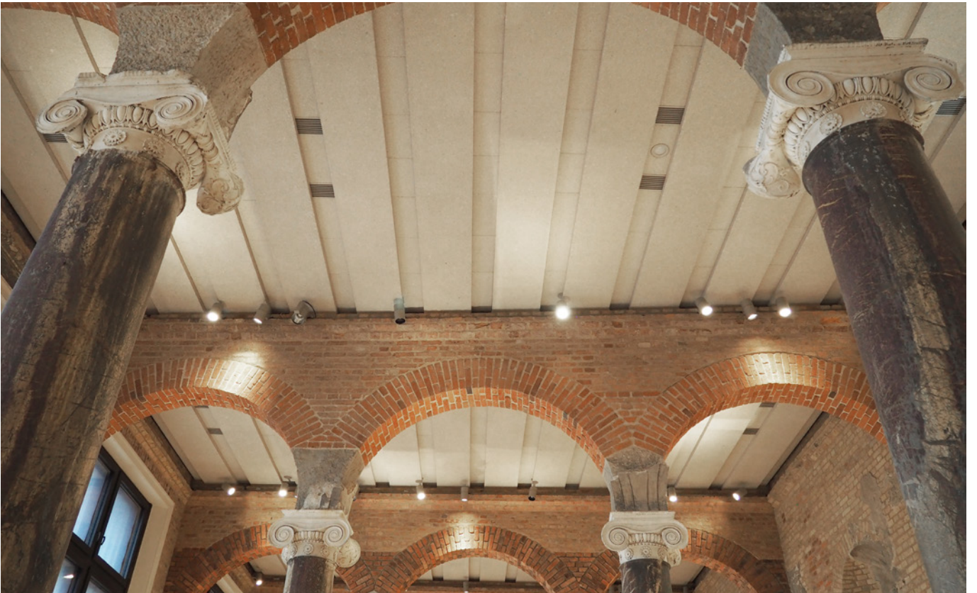
5.125. La sala Moderna, [foto: Antonio Acocella].
