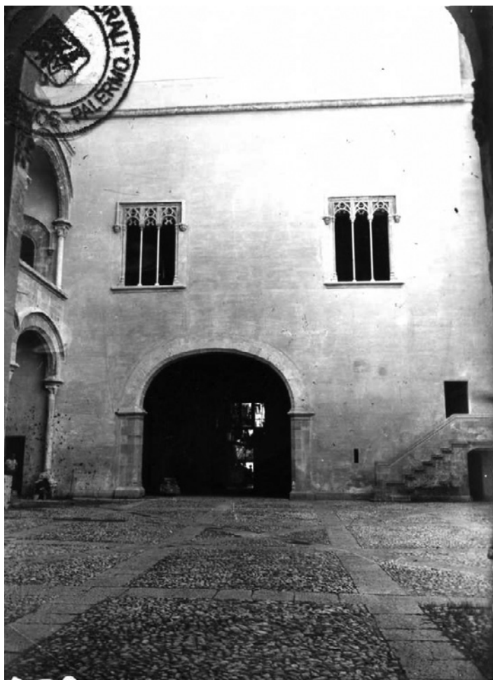
4.44. Il cortile ricostruito, [AFSMP, n. 514, 08.1954].
