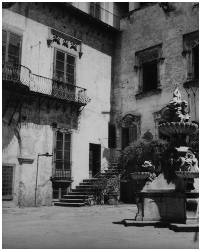
4.26. La scala metallica, [AFSMP, n. 391, 08.1940].
