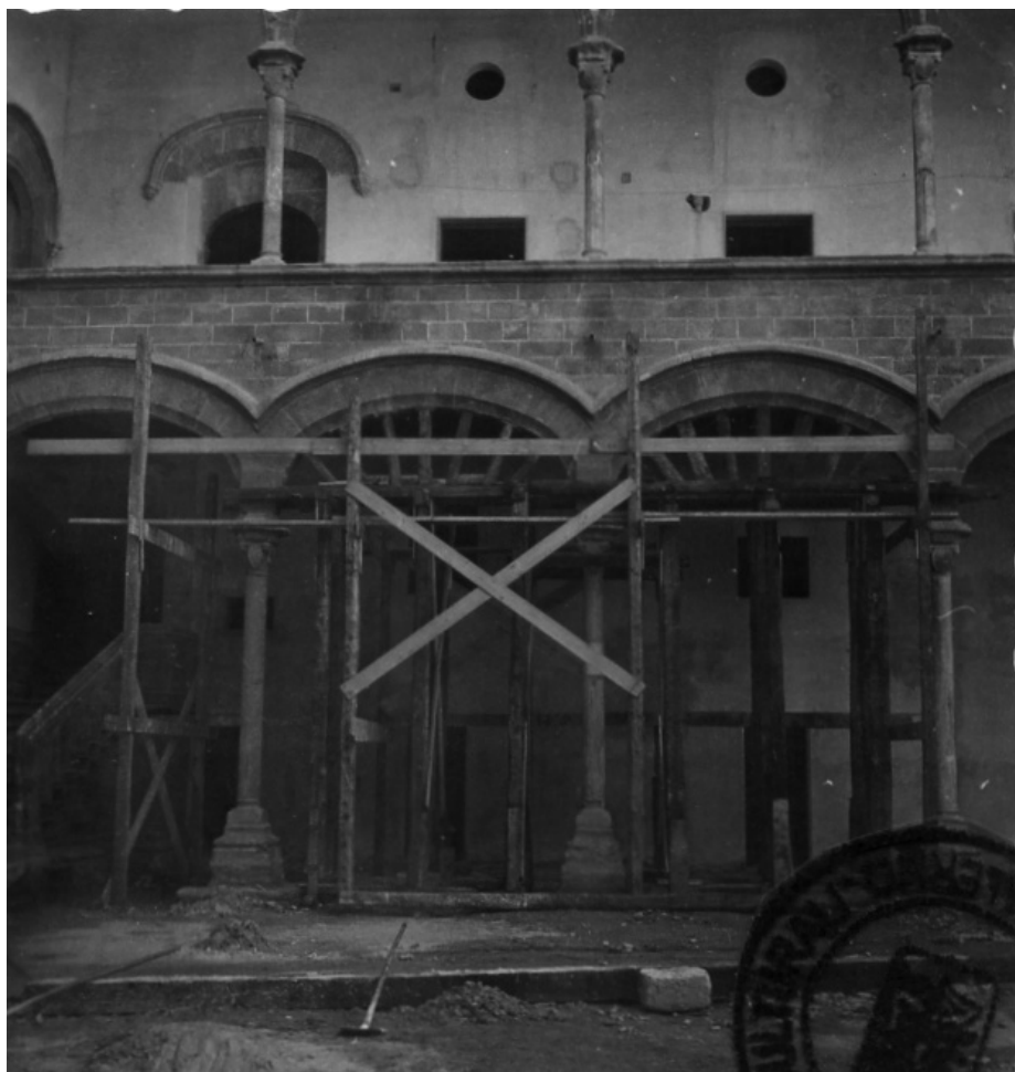
4.38. I lavori di ricostruzione del loggiato, [AFSMP, n. 668, 11.1951].
