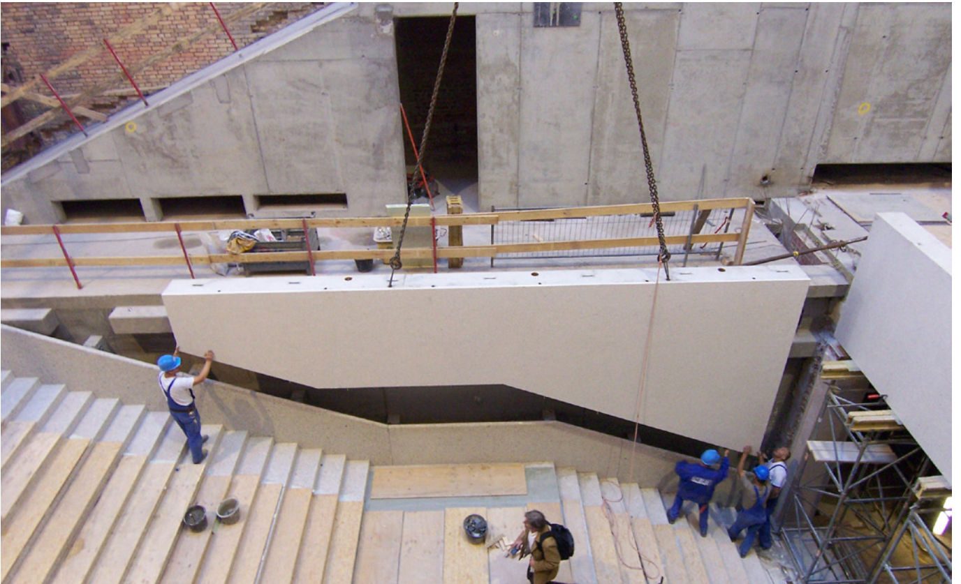
5.90. La scala nella fase di cantiere, [DCAB].
