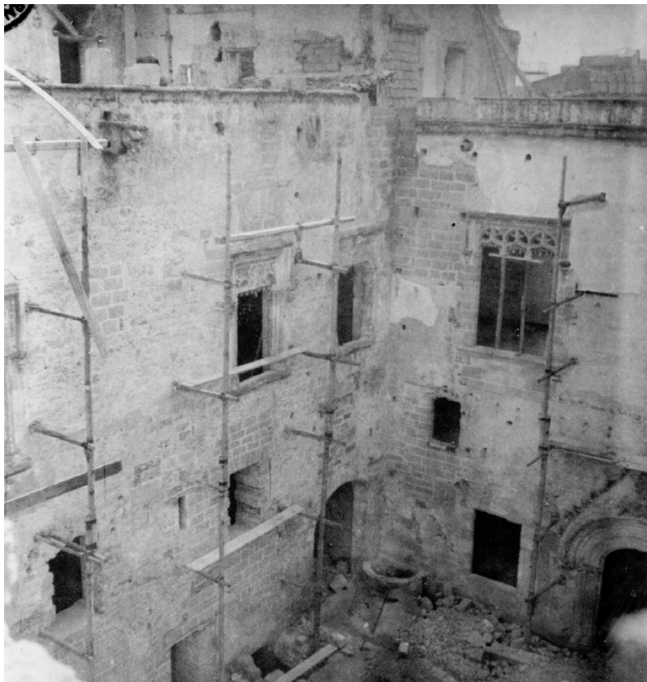
4.46. I lavori di ricostruzione alle facciate sul cortile, [AFSMP, n. 304, s.d.].
