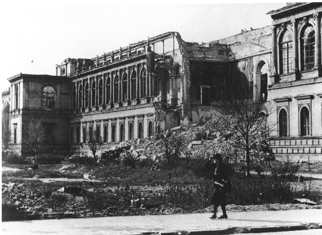
3.31. La lacuna sulla facciata meridionale, [BStGS, da: Hipp, Shaveh, 2011].
