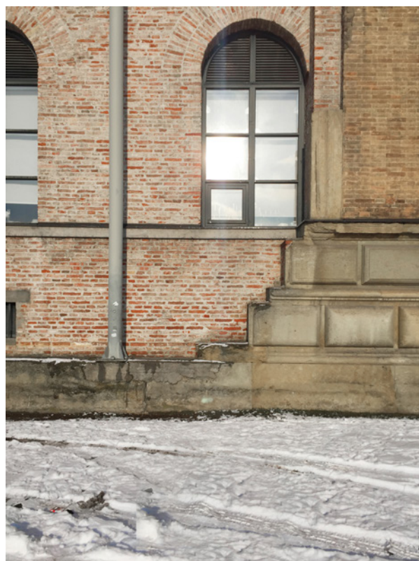
3.78. La facciata meridionale, [foto: Antonio Acocella].
