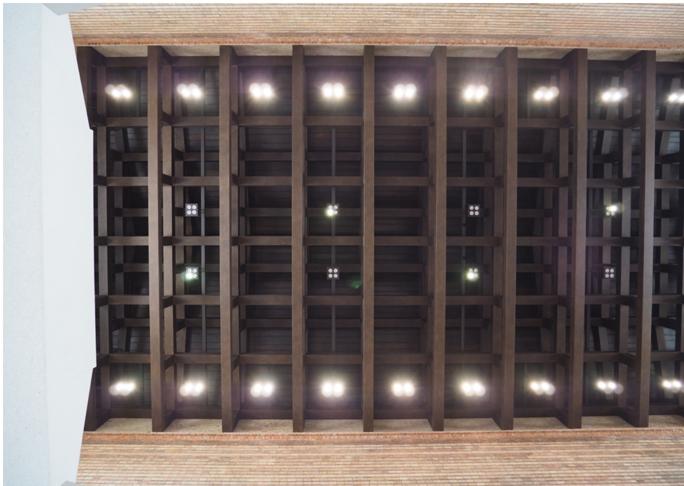
5.134. La reinterpretazione della copertura originaria, [foto: Antonio Acocella].
