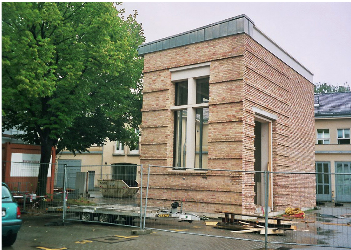
5.95. Mock-up di una porzione della facciata, [da: Thomas Benk, DCAB].
