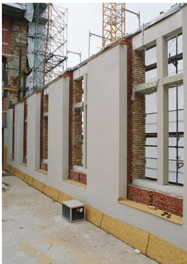
5.96. La facciata ovest in fase di realizzazione, [foto: Johannes Bennke, DCAB].
