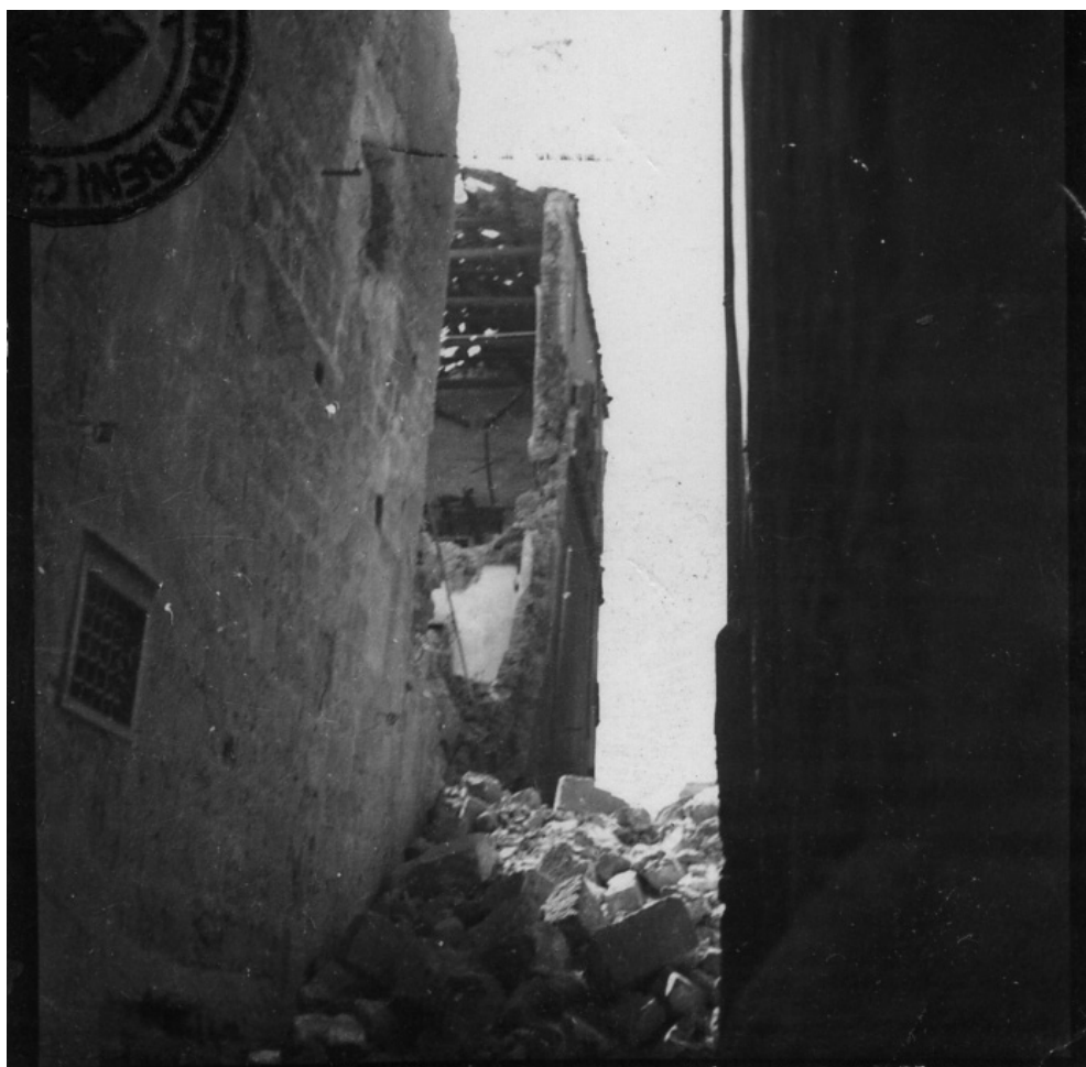
4.34. La facciata su via della Salvezza in rovina, [AFSMP, n. 352, 03.1943].
