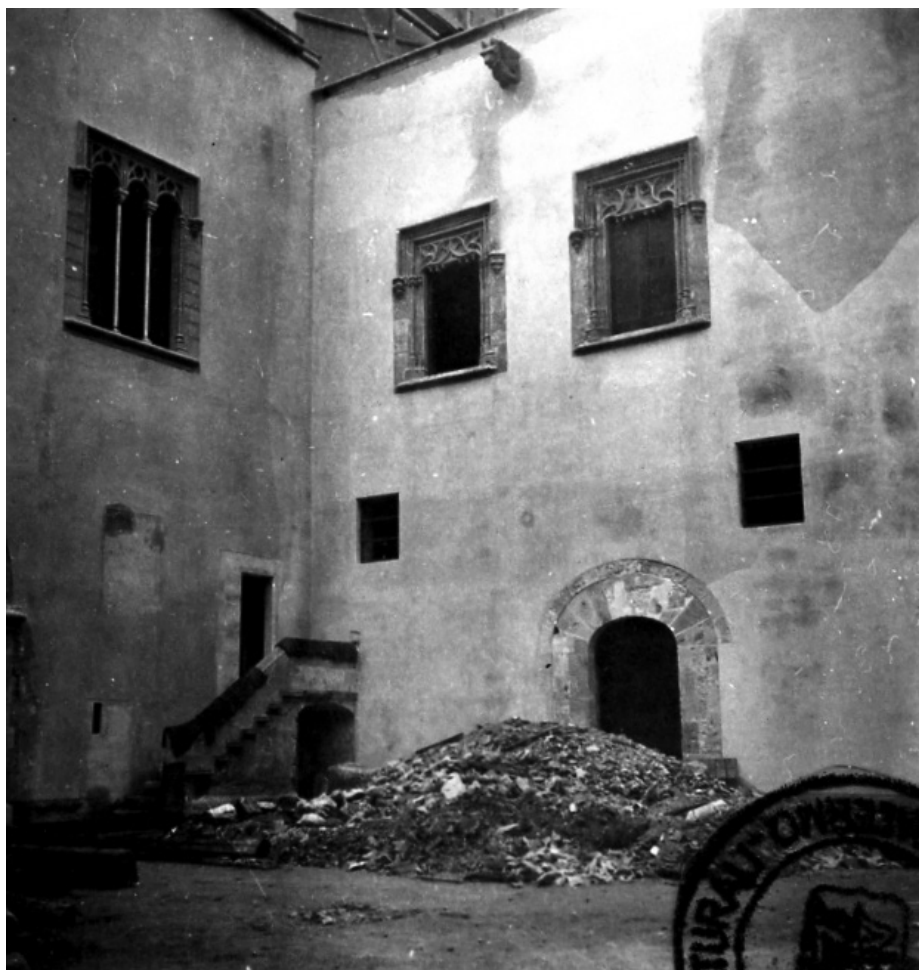
4.42. I lavori di ricostruzione sulla scala, [AFSMP, n. 96, 11.1952].
