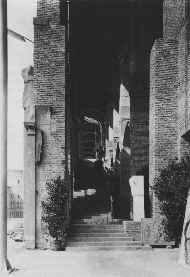
3.70. I lavori di ricostruzione della scala, [da: Altenhöfer, 1996].
