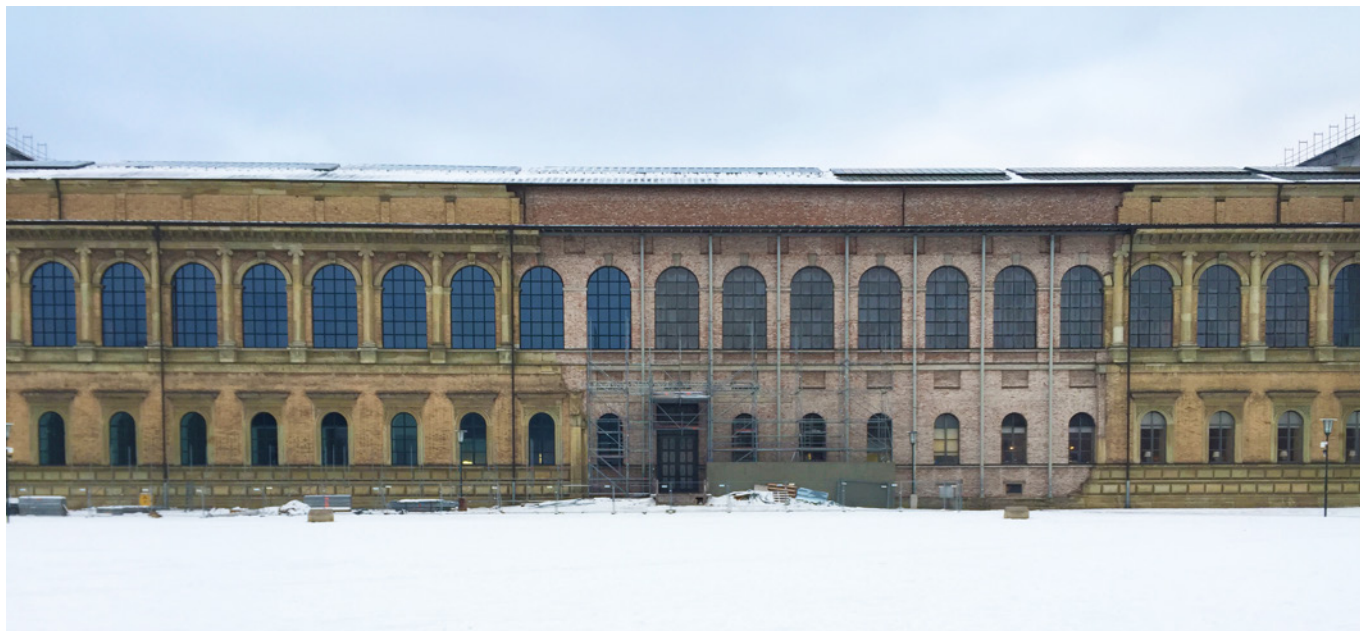
3.76. La facciata meridionale, [foto: Antonio Acocella].
