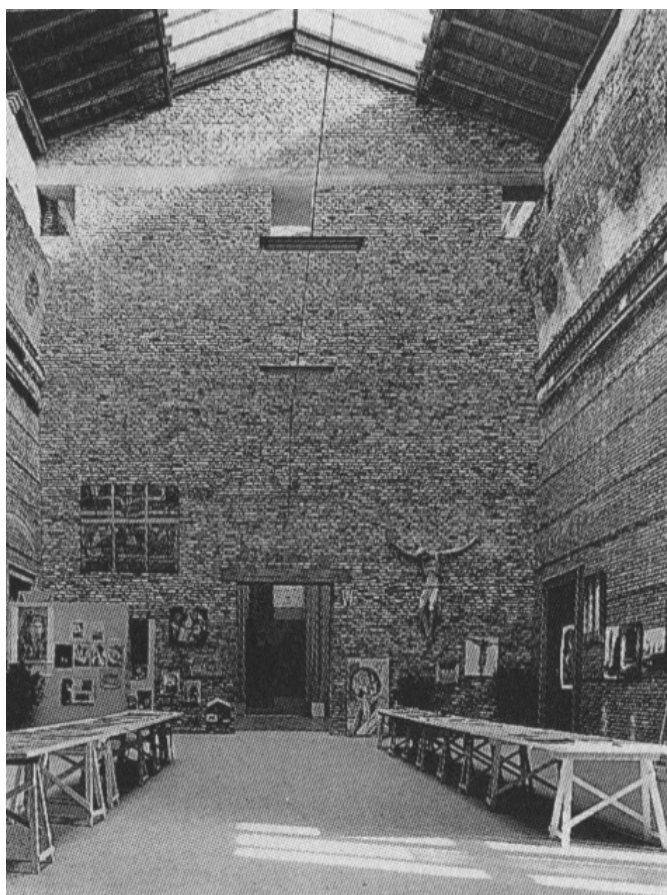
3.73. Una sala durante i lavori di ricostruzione, [da: Altenhöfer, 1996].
