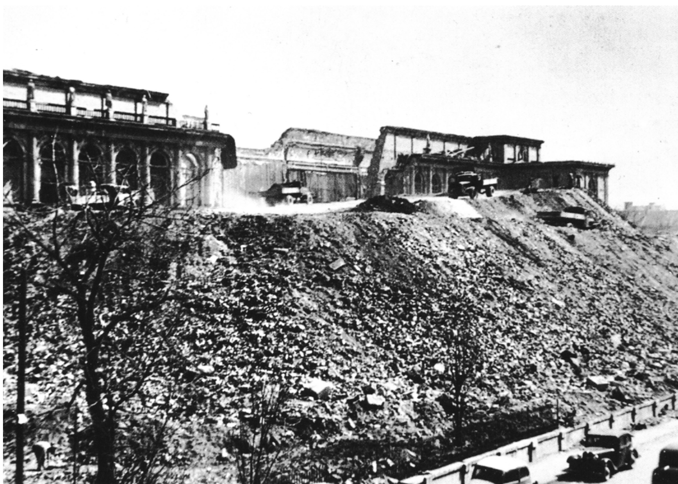
3.32. La montagna di macerie di fronte alla facciata meridionale, [BStGS, da: Hipp, Shaveh, 2011].
