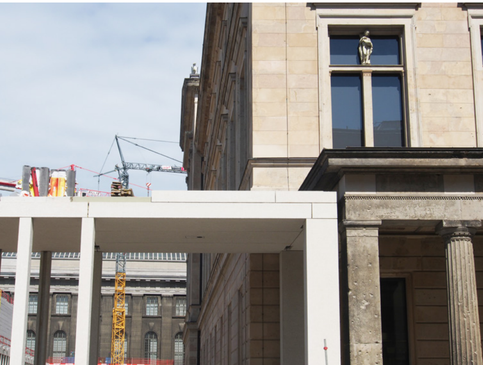
5.142. Il collegamento tra Neues Museum e James Simon Galerie, [foto: Antonio Acocella].
