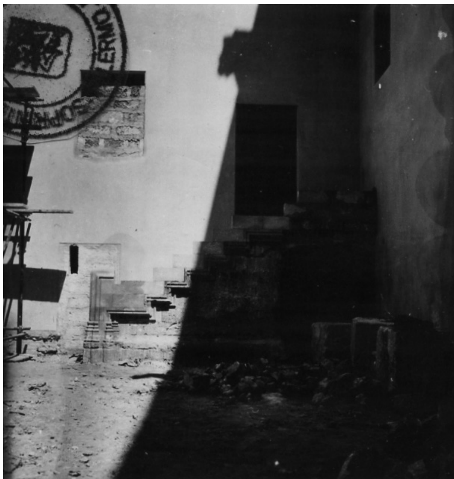
4.40. I lavori di ricostruzione sulla scala, [AFSMP, n. 220, 08.1952].
