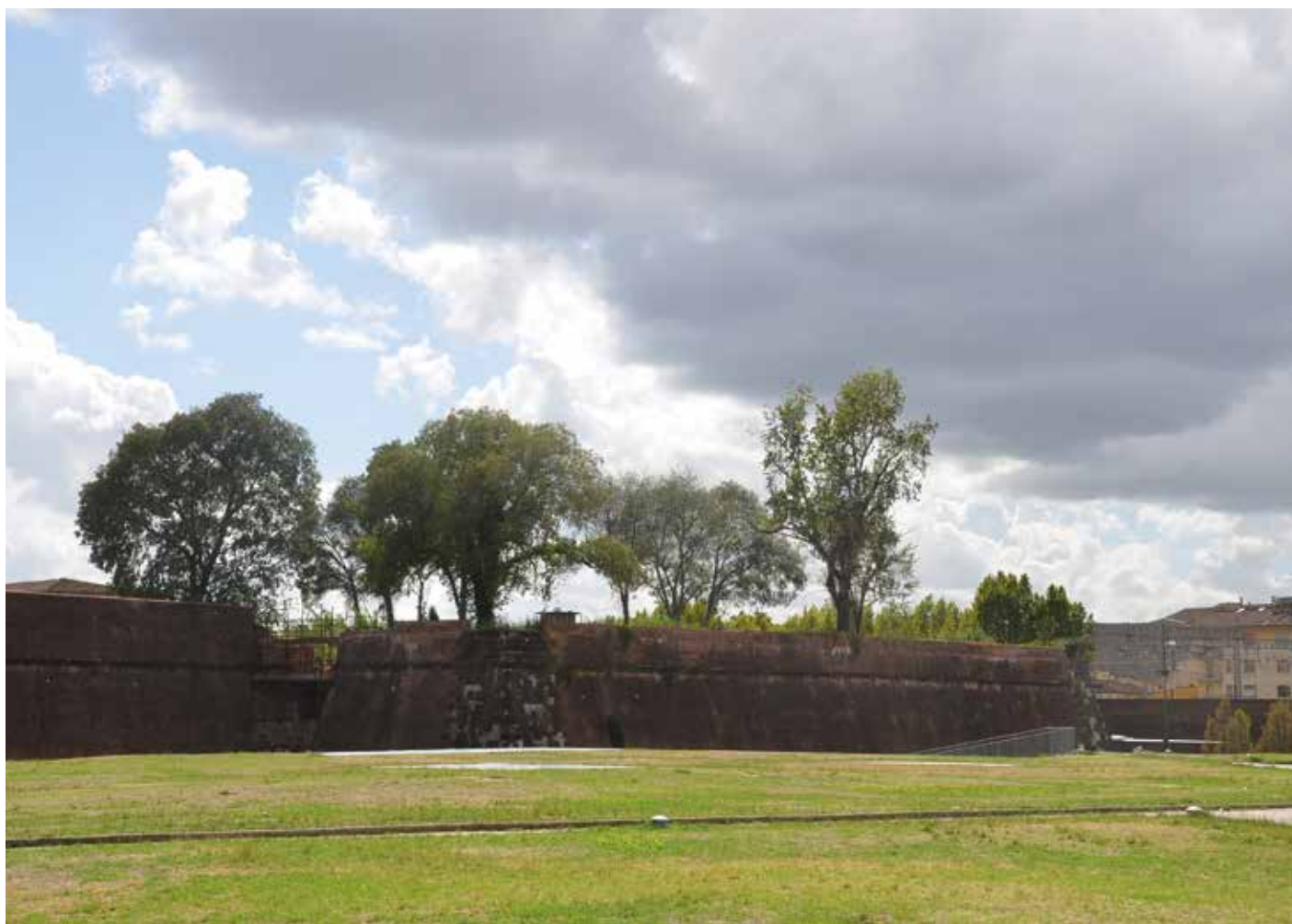
Fig. 2 La Fortezza vista dalla copertura del parcheggio sotterraneo che, costruito in prossimità delle mura, ha contribuito a falsare i rapporti percettivi tra il complesso e la città
