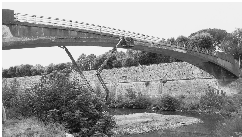
Fig. 3: La "Passerella" di Giulio Krall oggi in restauro (Foto dell'autore)
