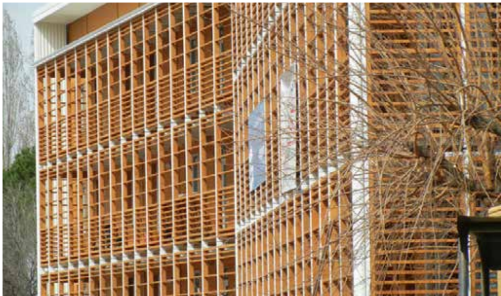
Fig.4_ Condominio prefabbricato “Abitare Temporaneo” a Firenze – Casa Spa. Tratto da arketipomagazine.it
