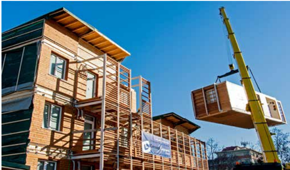
Fig.2 Una fase del cantiere con il sollevamento e la movimentazione di uno dei moduli prefabbricati che compongono le abitazioni sociali.
