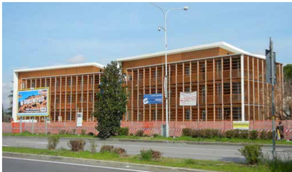
Fig.1_ Vista dei due edifici del complesso di alloggi temporanei di Viale Guidoni, nel quartiere di Novoli a Firenze.
