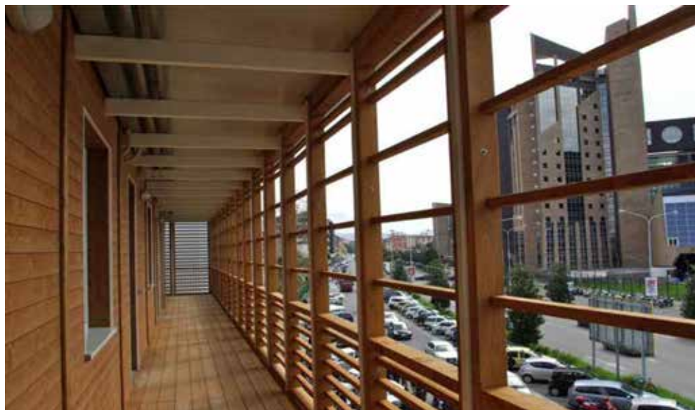
Fig.3 Scorcio del ballatoio con brise soleil in legno e sullo sfondo l'edificio del nuovo Palazzo di Giustizia di Firenze.
