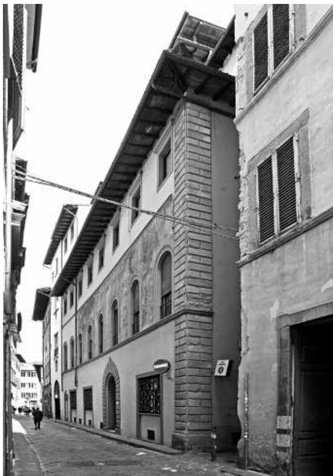
Fig. 124. Palazzo Mazzinghi; Firenze, via delle Belle Donne.
