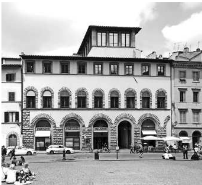
Fig. 100. Palazzo di Francesco di Piero Pitti (poi Temple Leader); Firenze, piazza Pitti.
