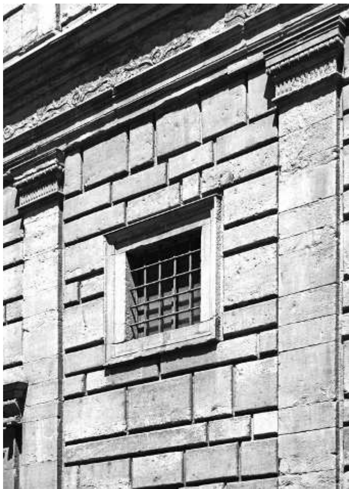
Fig. 27. Palazzo Rucellai, dettaglio del bugnato al piano terreno; Firenze, via della Vigna Nuova.
