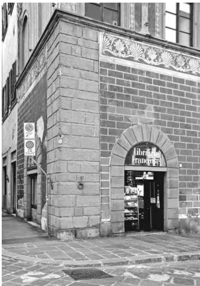
Fig. 122. Palazzo Lenzi, la fascia bugnata all'angolo fra piazza Ognissanti e via Montebello; Firenze, piazza Ognissanti.
