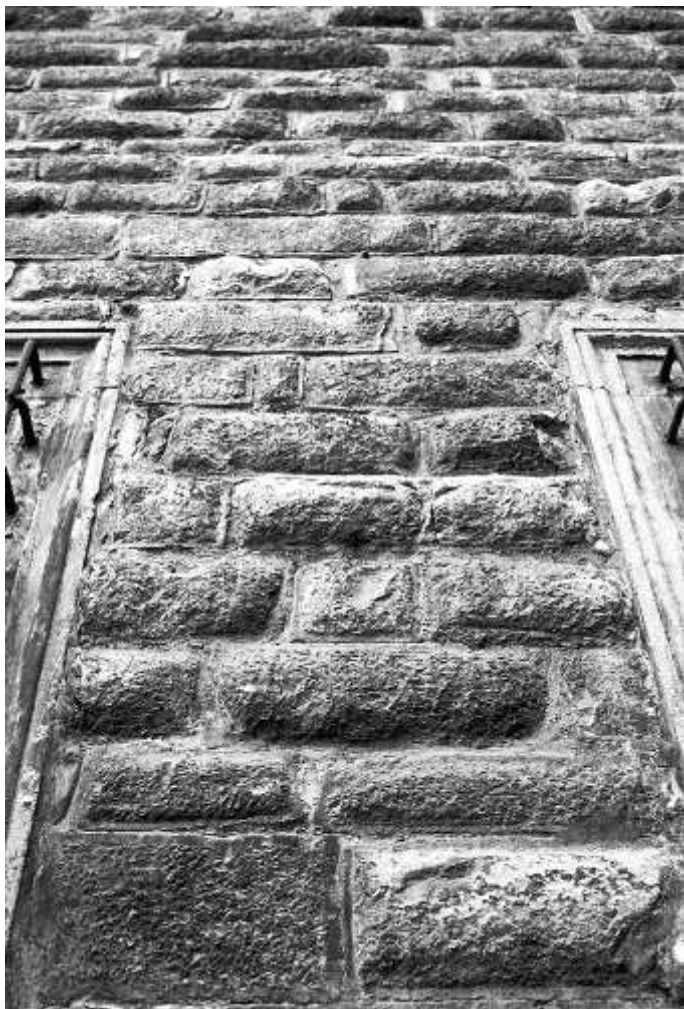
Fig. 40. Palazzo Scolari, dettaglio del paramento (bugne E frammischiata a bugne B e B 1 ); Firenze, via de' Giraldi.
