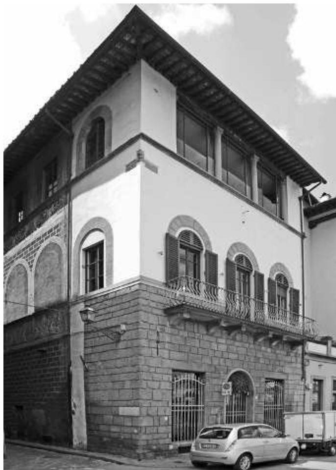
Fig. 91. Palazzo Capponi-Coverelli; Firenze, via Santo Spirito.
