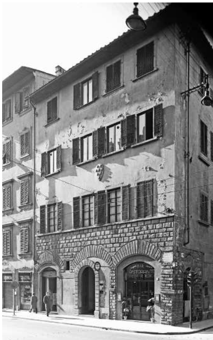
Fig. 59. Palazzo Vai; Firenze, via Cavour.
