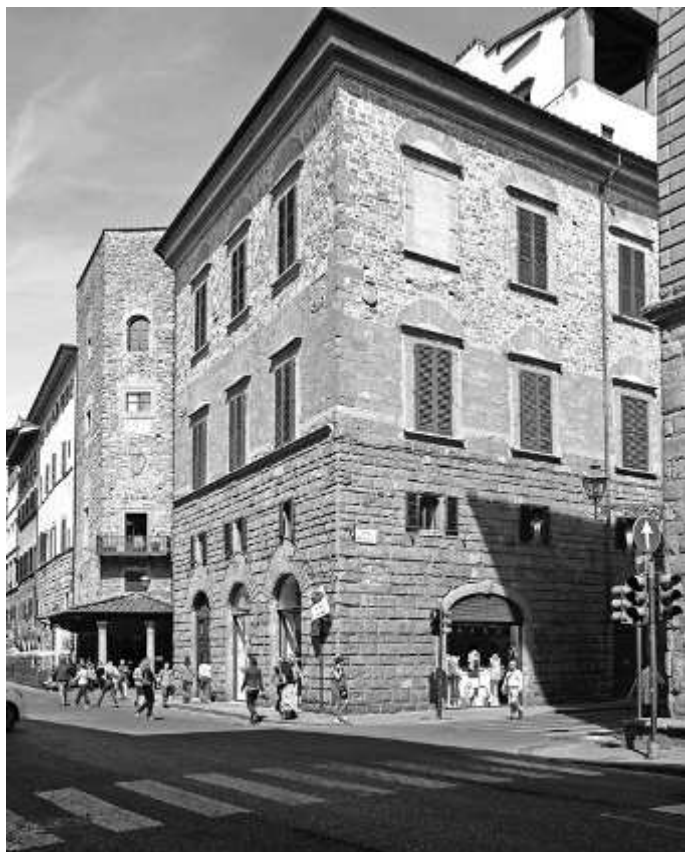
Fig. 76. Loggia de' Cerchi, il superstito pilastro angolare; Firenze, via de' Cerchi.
