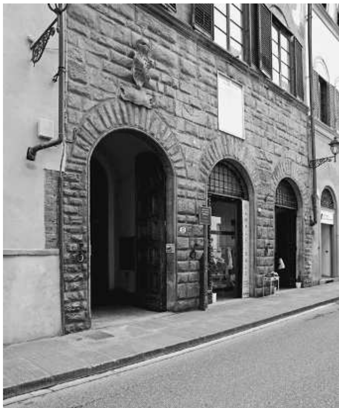
Fig. 63. Palazzo Corbinelli; Firenze, via Maggio.
