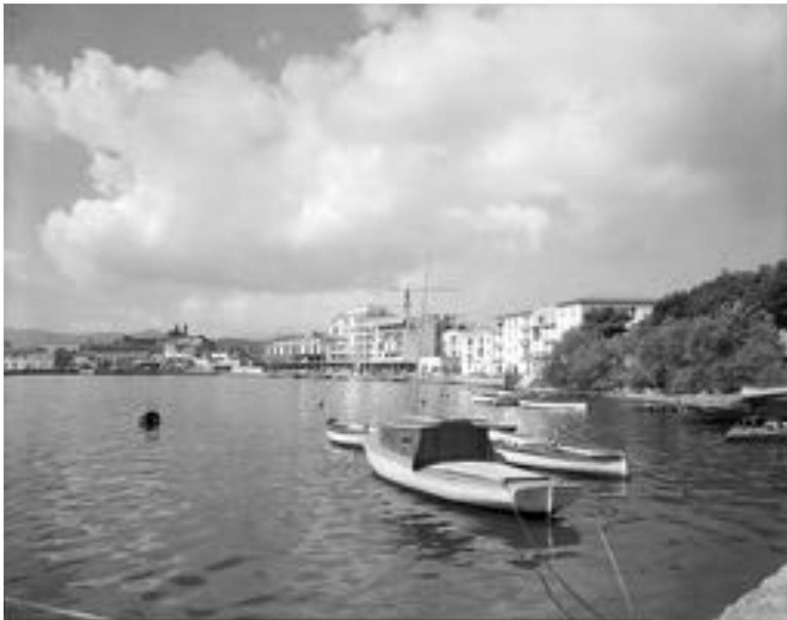
Fig. 2 Il nuovo fronte sul porto di Portoferraio in costruzione, in una foto del 1964.
