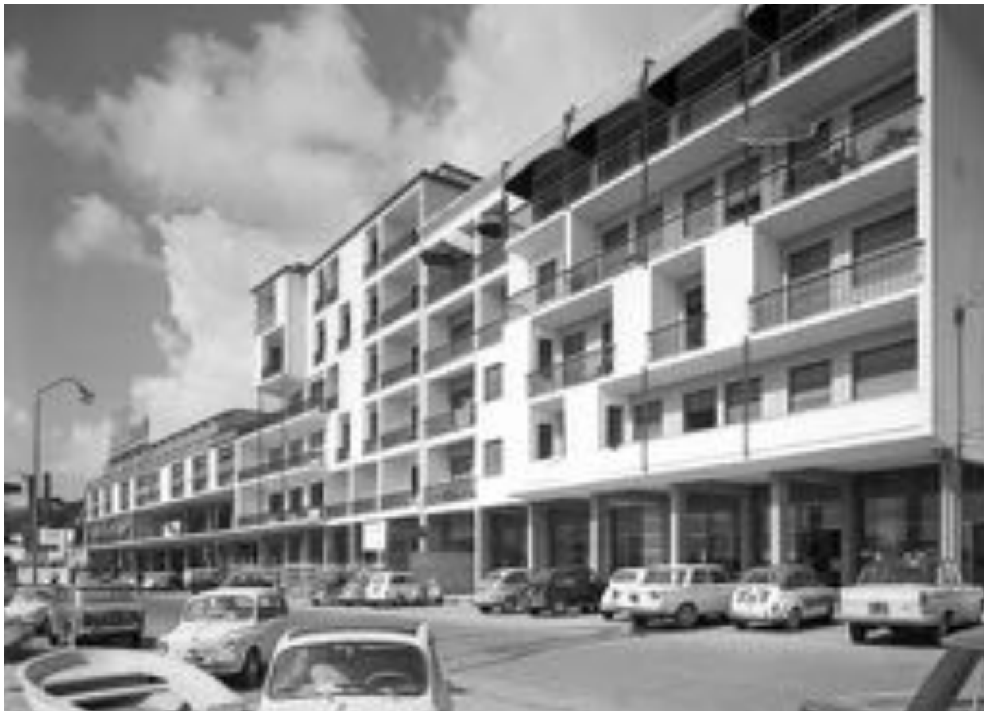
Fig. 28 La Palazzata di Portoferraio in costruzione.
