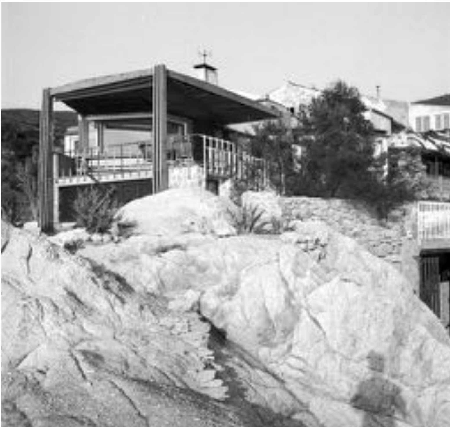
Fig. 99 Vista del prospetto nord in una foto dell'epoca.
