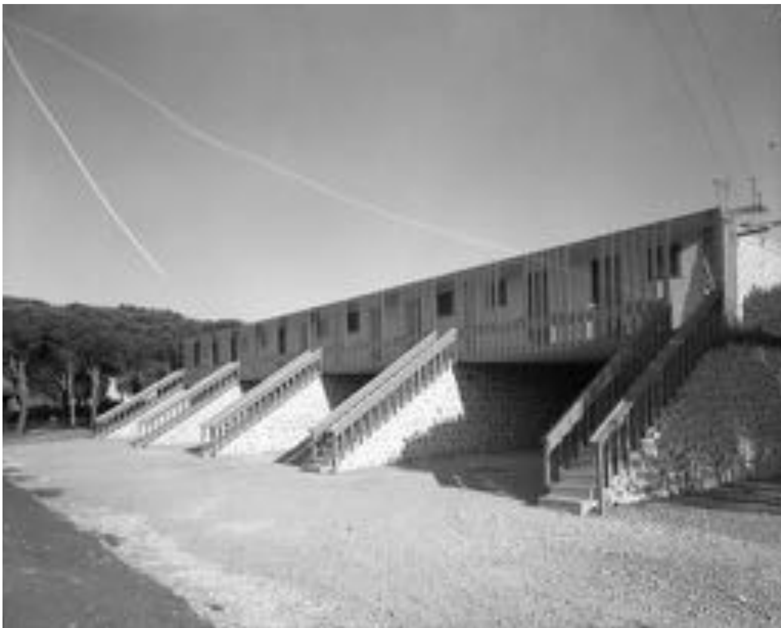
Fig. 118 Veduta del prospetto nord in costruzione.
