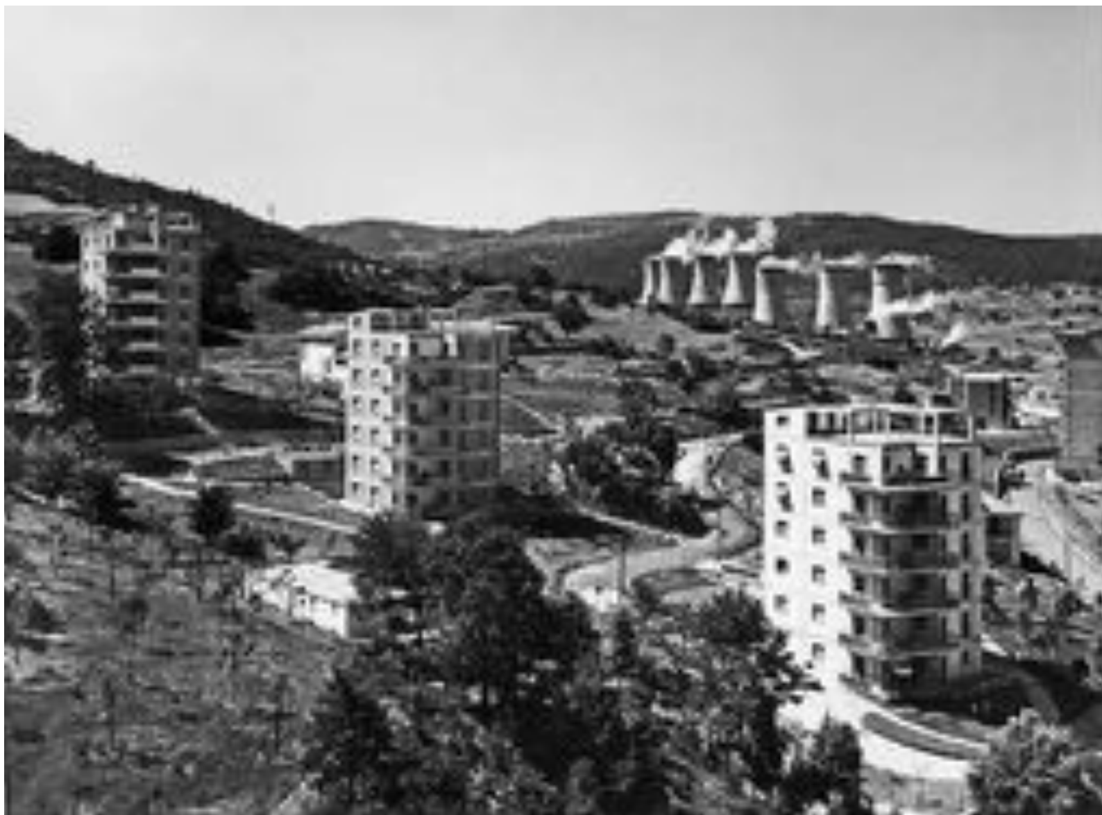
Fig. 8 Case Torri, Villaggio Operaio, Larderello, Pisa, 1955-1956, in una foto dell'epoca.
