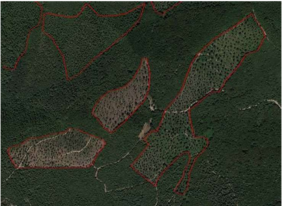
Fig. 20 - Particolare dell'area interessata dal taglio nel 2016, a lavori ultimati.
