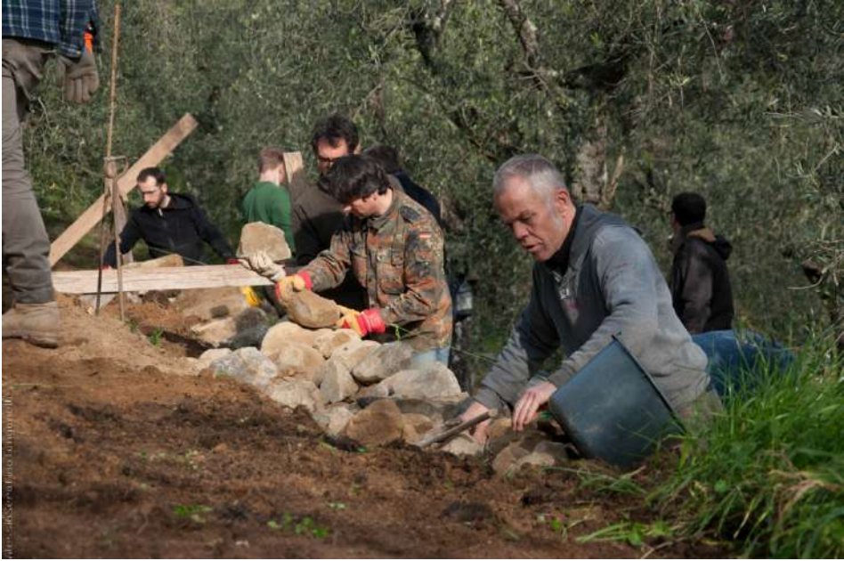
Fig. 26 - Corso di ricostruzione dei muretti a secco. Attività promossa dall'Associazione Bio-Distretto del Montalbano.
