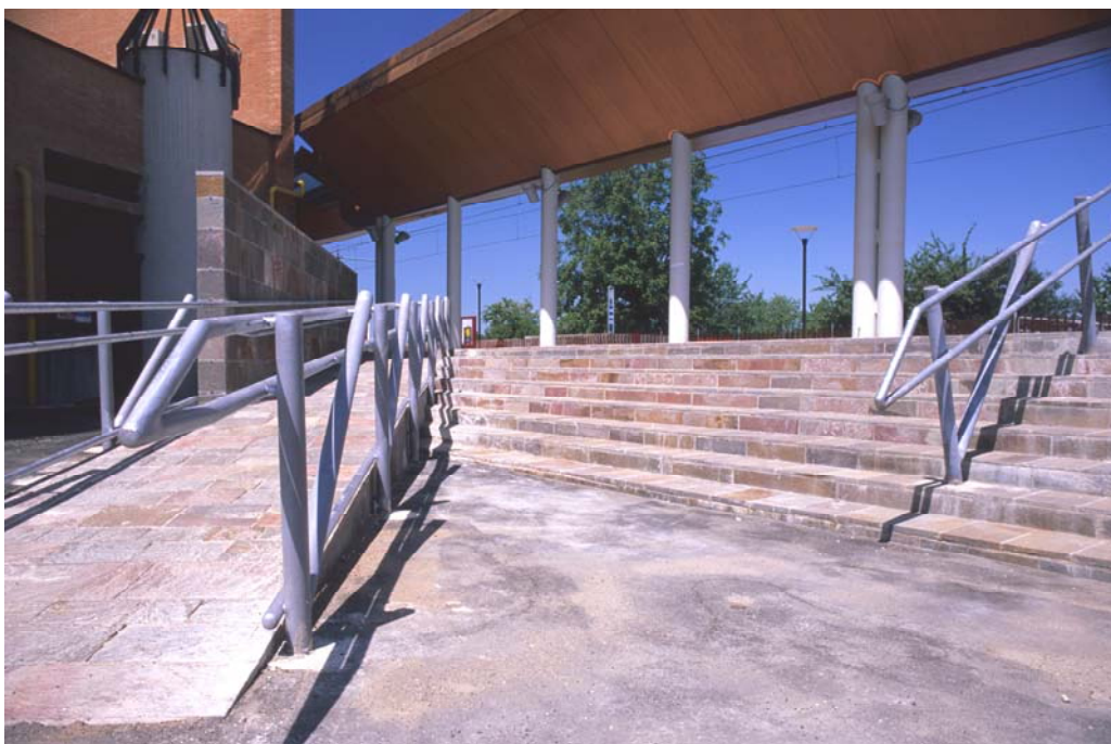
Fig. 2. Accesso alla Stazione ferroviaria di Zola Municipio.
