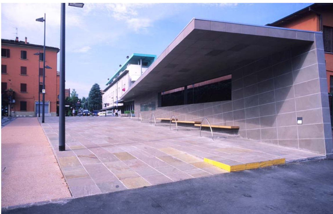
Fig. 3. Piazzetta coperta introduttiva al nuovo sistema civico-culturale di Zola Predosa.
