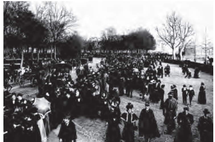
Viale della Regina (end of the nineteenth century)
