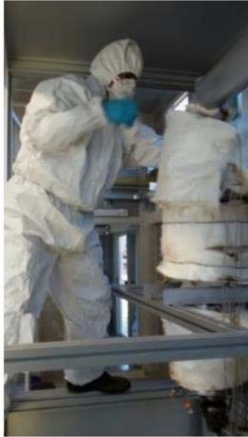
Smontaggio coibentazione esterna
