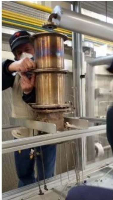
Smontaggio raccordo tubazione di scarico
