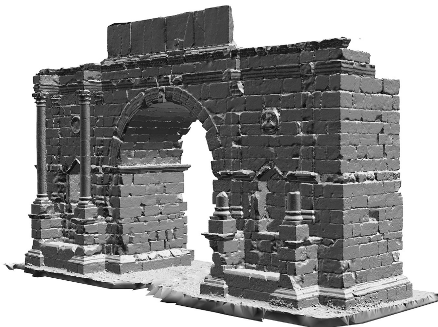
Fig. 8 - Il modello 3D Mesh Model dell'arco ottenuto dall'elaborazione delle immagini fotografiche con 3DF Zephyr.
