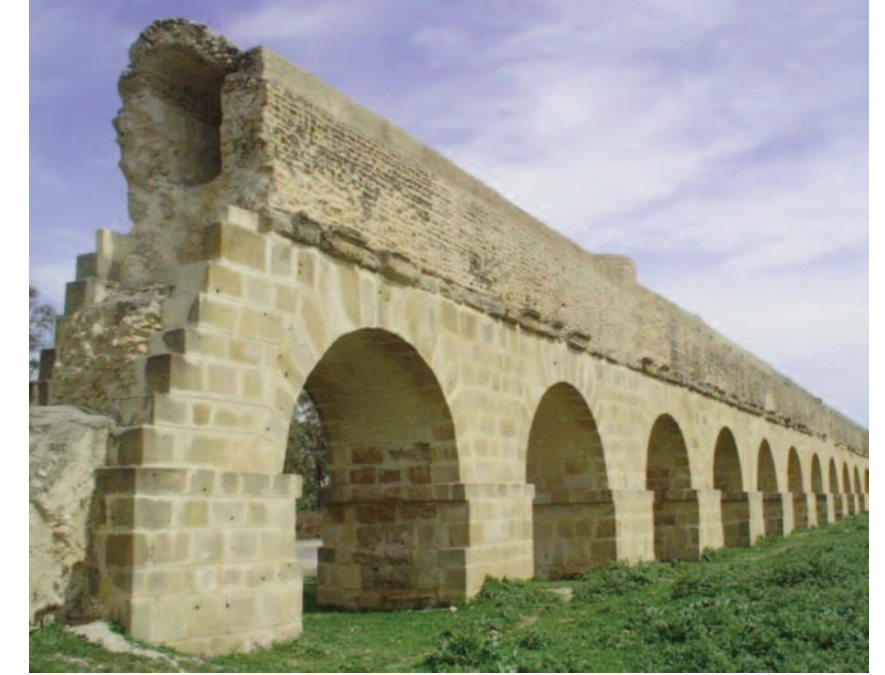
Fig. 2. Strutture restaurate dell'antico acquedotto romano.
