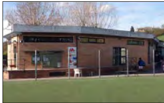
Attraverso il fotorilevamento, applicato alla elaborazione del rilievo integrato mediante laser scanner, sono state eseguite le sezioni e i prospetti delle maggiori strutture edilizie presenti nell'impianto quali gli spogliatoi.
