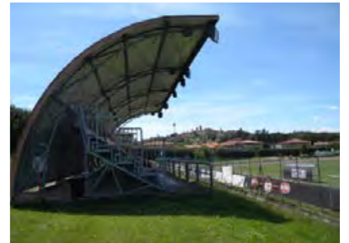
Attraverso l'elaborazione del rilievo integrato mediante laser scanner, integrato con lo sviluppo della nuvola di punti con il programma Cyclone, è stato possibile rappresentare i prospetti della tribuna coperta, con le relative restituzioni a fil di ferro.
