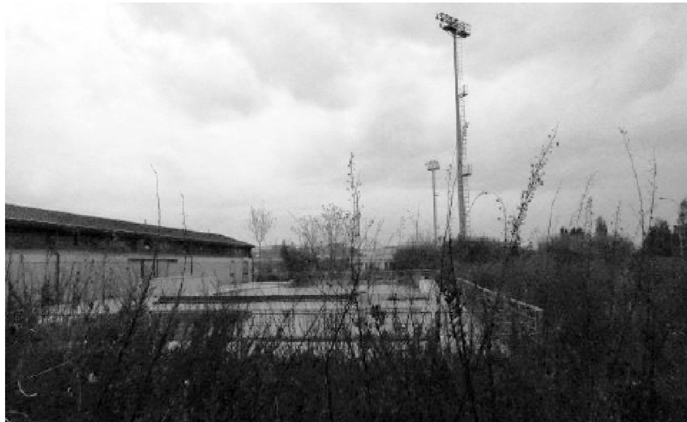
Sopra e nella foto di sotto report dell'impianto sportivo Val di Rose nel degrado, di proprietà dell'Università di Firenze.
