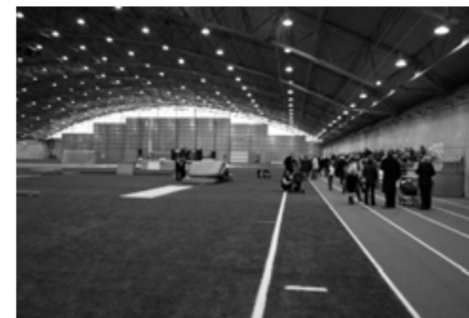
Esempio di un impianto sportivo per la pratica del calcio caratterizzato da una copertura che consenta la pratica anche durante i mesi più rigidi dell'anno.
