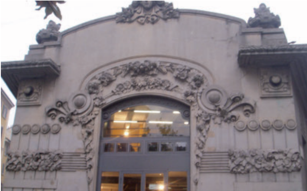
La facciata Liberty della biblioteca Venezia.
