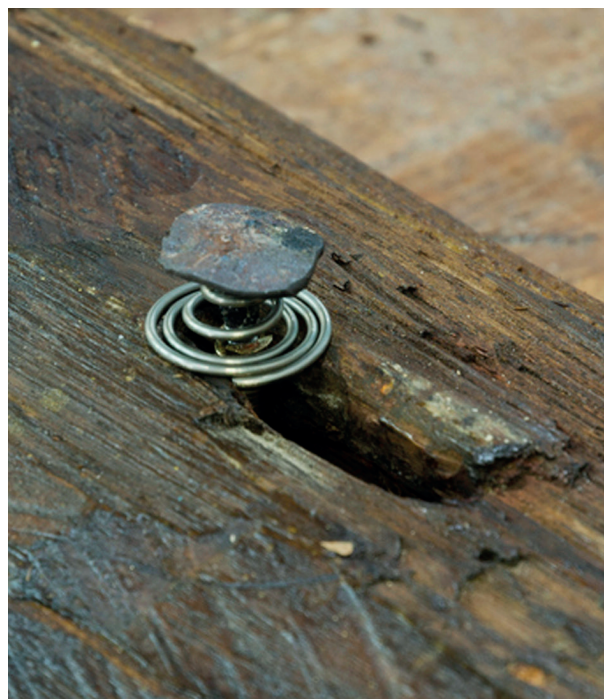
17. Un particolare del nuovo ancoraggio delle traverse; tra la testa del chiodo e la traversa viene inserita una molla, registrabile mediante il parziale avvvitamento/svitamento della testa stessa.
