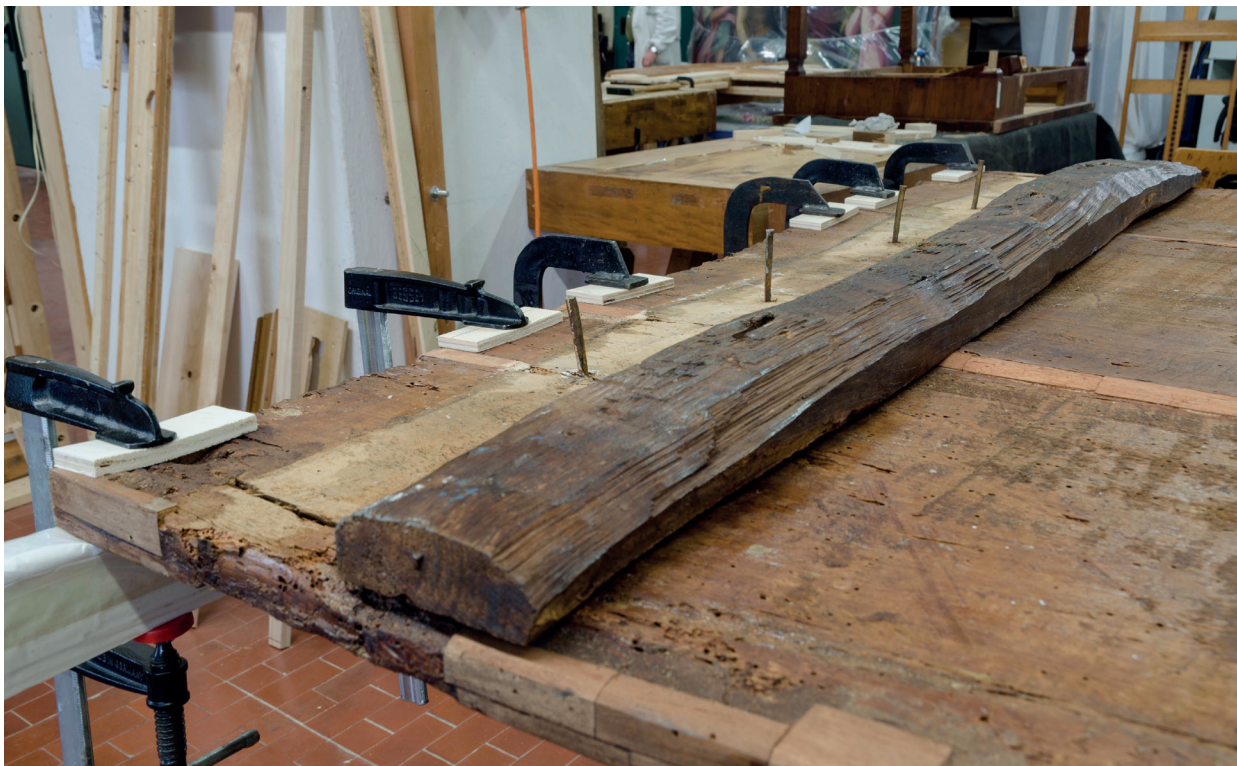
8. La traversa superiore dopo la rimozione.
