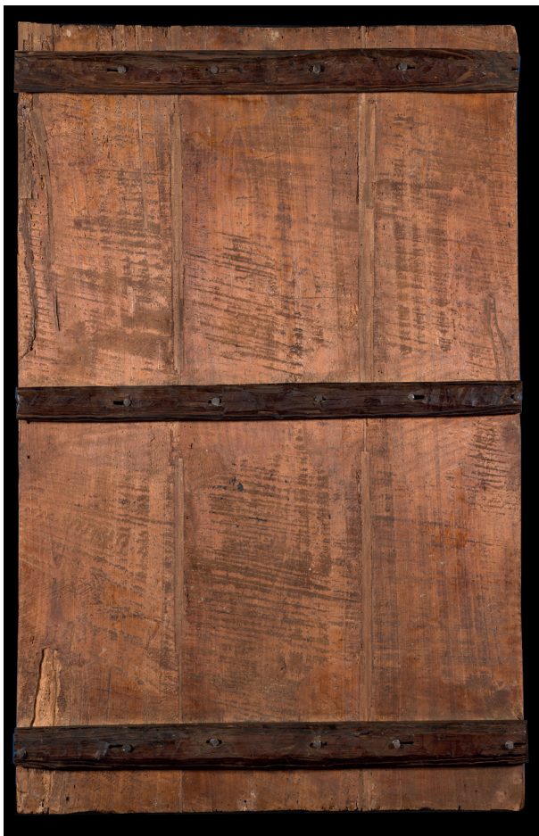
18. Il supporto ligneo dopo il restauro; tutti gli elementi che formavano la struttura originale sono stati mantenuti e resi funzionali per la corretta conservazione dell'opera.
