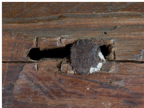
4. Particolare di un chiodo di tenuta di una traversa alloggiato in un foro ad asola.
