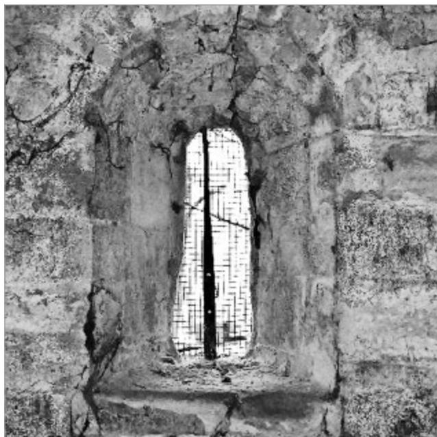
fig. 16 – La risega di fondazione a vista con le tracce di intonaco che documentano l’attacco del pavimento presente prima della costruzione della cripta e la monofora presente nell’abside di prima fase
