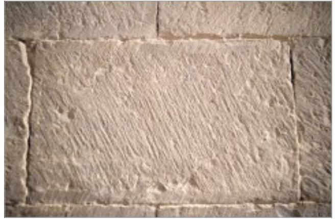
fig. 13 – A sinistra: conci utilizzati nella prima fase di costruzione dell’edificio dove si nota un impiego della sabbia per la finitura esterna della superficie delle pietre. A destra: un concio della seconda fase costruttiva che presenta una lavorazione (con presenza del nastrino) e una finitura eseguita con scalpello.
