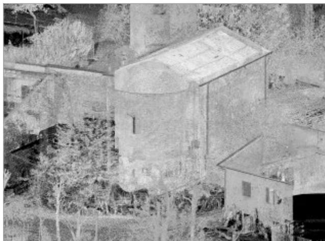
fig. 26 – La nuvola di punti nel rilievo laser scanner della Pieve di Buiano.
