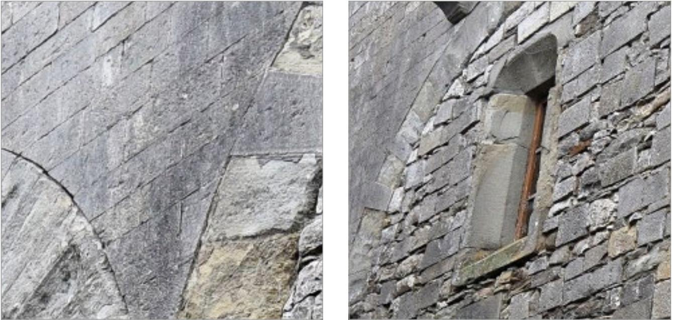
fig. 9 – Prospetto Nord esterno. A sinistra, un particolare delle arcate che dividevano la navata centrale da quella laterale e della muratura in blocchetti di calcarenite impiegata durante la seconda fase di costruzione della chiesa utilizzata anche nella sostituzioni alcuni cunei dell'arco. A destra, il tamponamento dell'arcata centrale mediante l'utilizzo di materiale misto e di riempigio con la messa in opera di una monofora.
