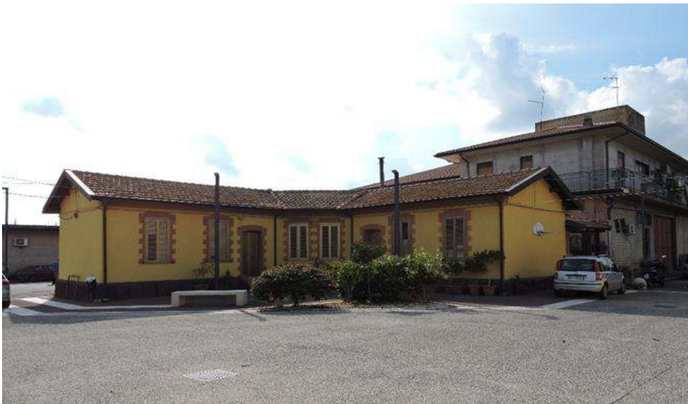
Fig. 2 Sferro Village, province of Catania: a panoramic view of the building in the square Borgo Sferro, provincia di Catania: una vista attuale dell'edificio della piazza
