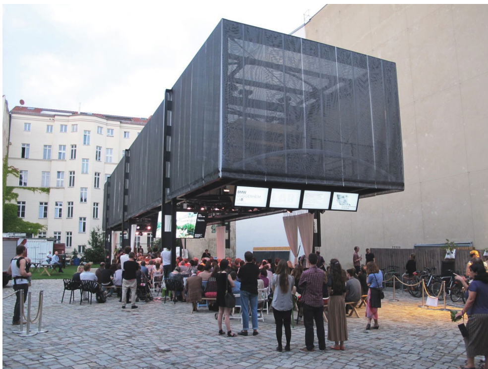
Il BMW Guggenheim Lab è un progetto che promuove modelli condivisi di vita nello spazio pubblico mettendo allo scoperto spazi residuali nelle città del mondo. Una loggia mobile attiva, comunica, raccoglie, ed educa.
