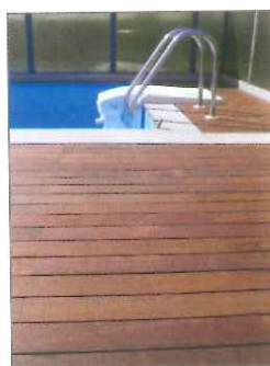
Decking di piscina di legno trattato termicamente (Foto Baschild, www.baschild.com ).
