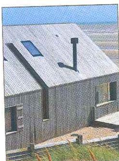
In alto “Ristorante onda” a Oslo, in basso casa sulla spiaggia a Camber Sands (UK) realizzati rispettivamente con legno di pino silvestre Kebony® e legno di pino radiata Kebony® ( https://kebono.com/en ). Le tavole “kebonizzate” stanno virando ad un colore grigio omogeneo che si completerà in un periodo di alcuni anni.
