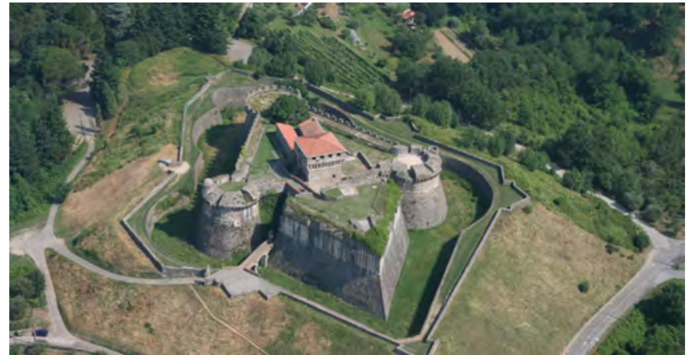
Fig. 14 Sarzana, vista della fortificazione sul colle di Sarzanello, di forma trianfolare con tre torrioni circolari e con l'ingresso protetto da un rivellino acuto
