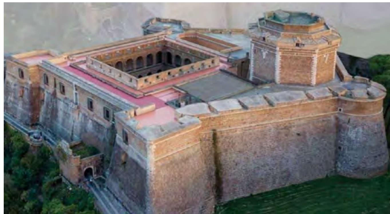
Fig. 17 Civita Castellana, vista della rocca con bastioni poligonali a fianchi ritirati, insieme ad alcuni vertici circolari, attribuito ad Antonio da Sangallo
