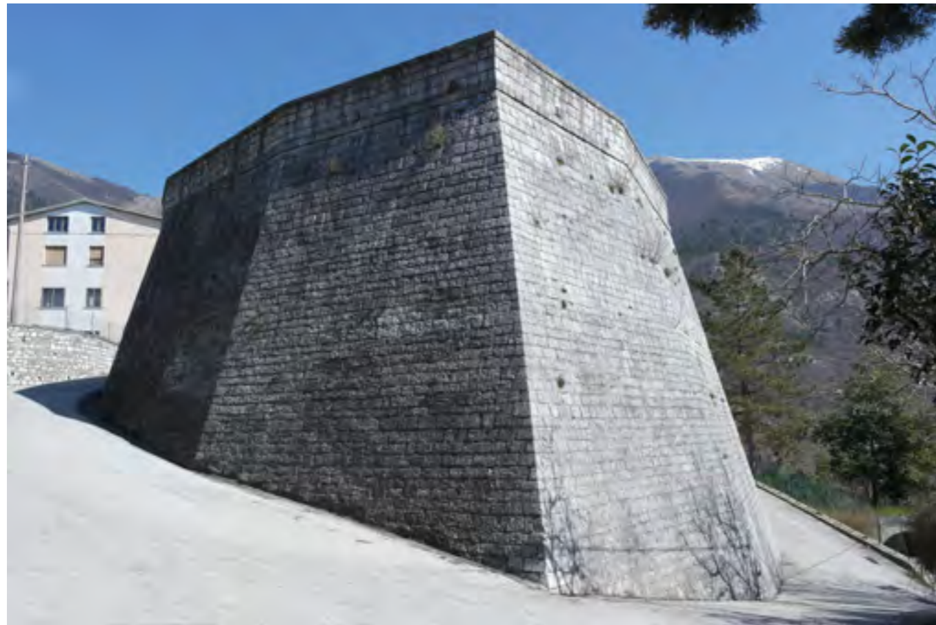
Fig. 10 Costacciaro, vista del rivellino di accesso alla città fortificata, progetto di Francesco di Giorgio Martini
