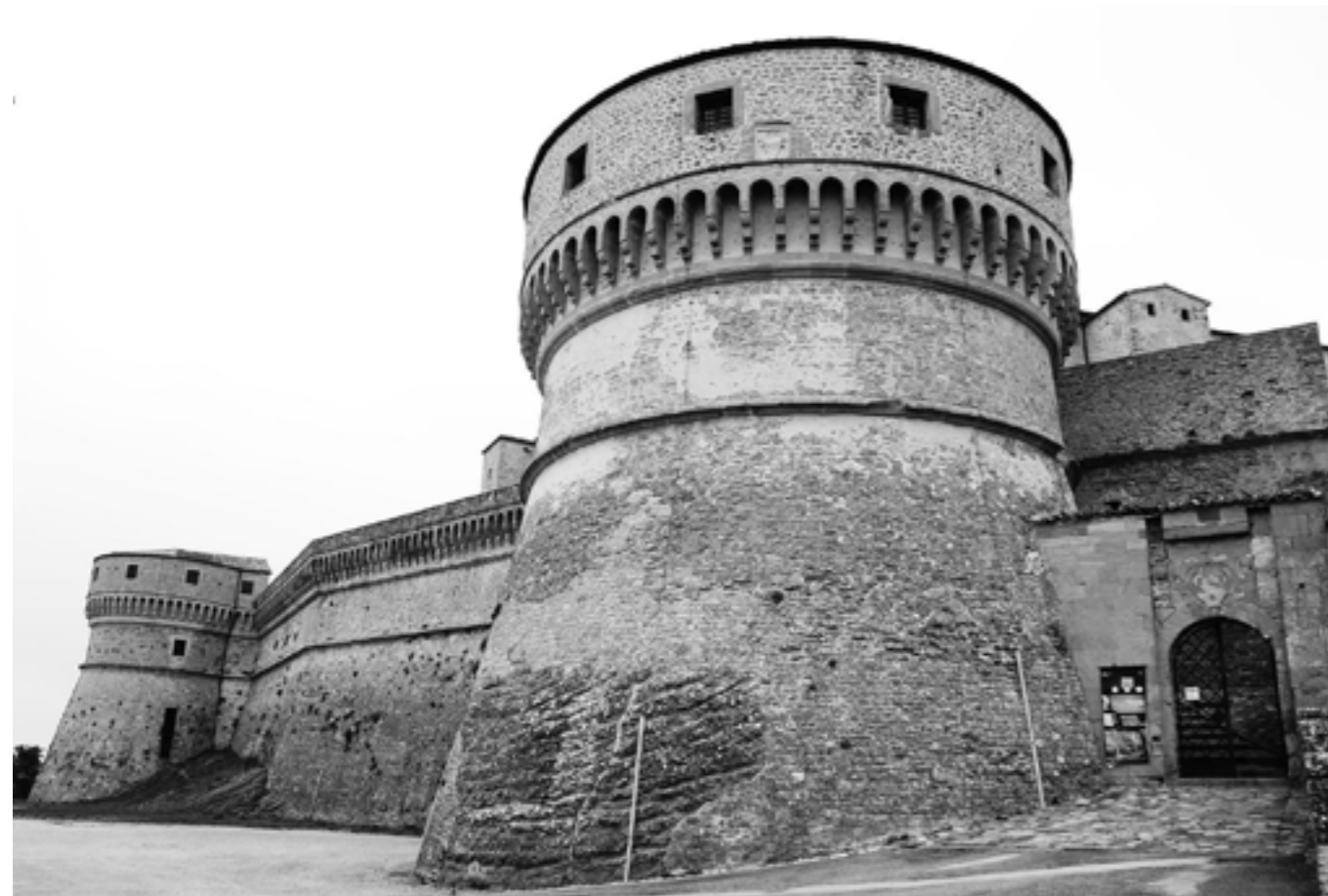
Fig. 12 San Leo, vista della fortificazione a protezione dell'accesso della città: due torrioni circolari con una cortina a forma di angolo acuto, Francesco di Giorgio Martini
