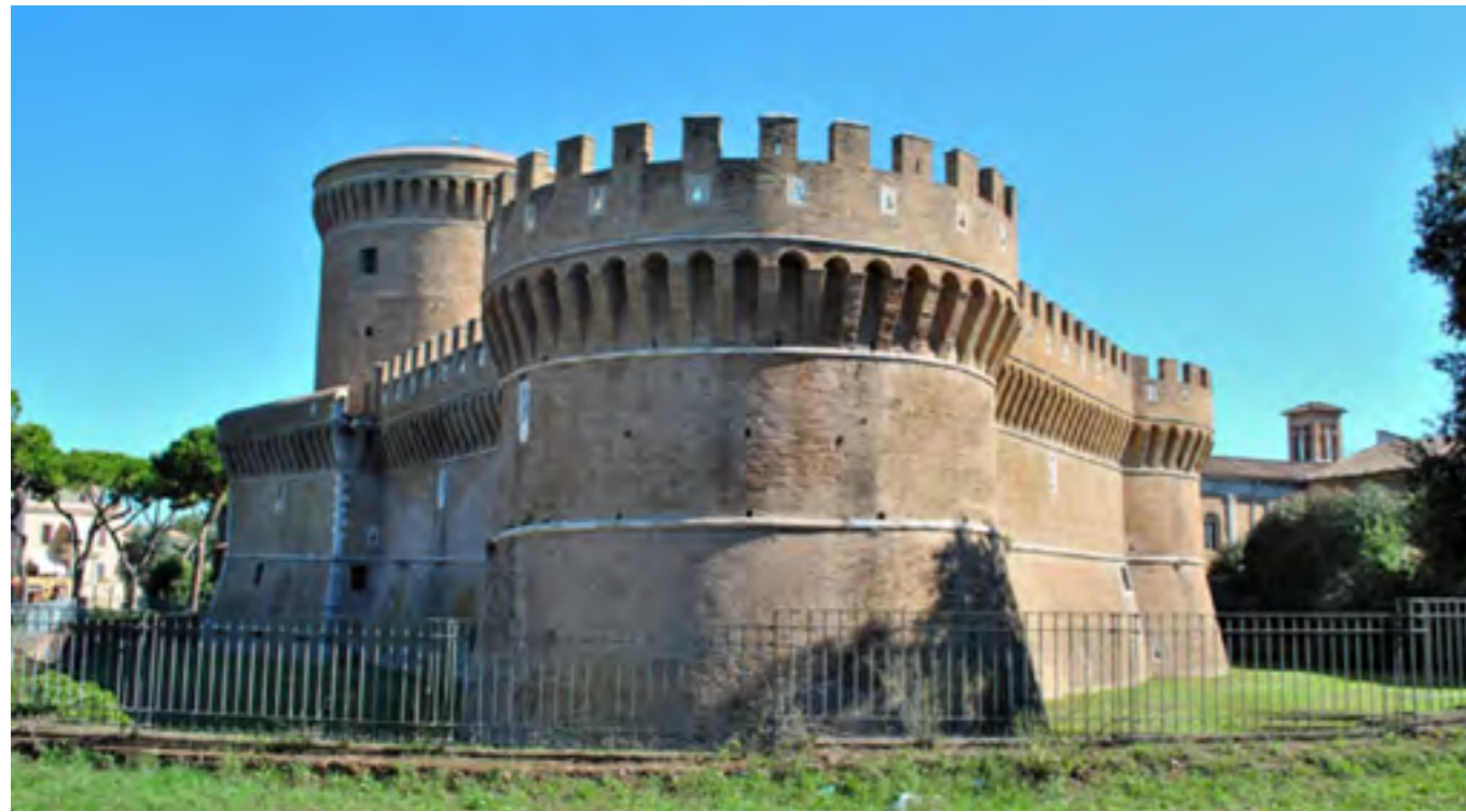
Fig. 15 Ostia, vista della roccaforte triangolare con torrioni circolari ai vertici, progettata da Bastio Poncelli, seguendo i principi di Francesco di Giorgio
