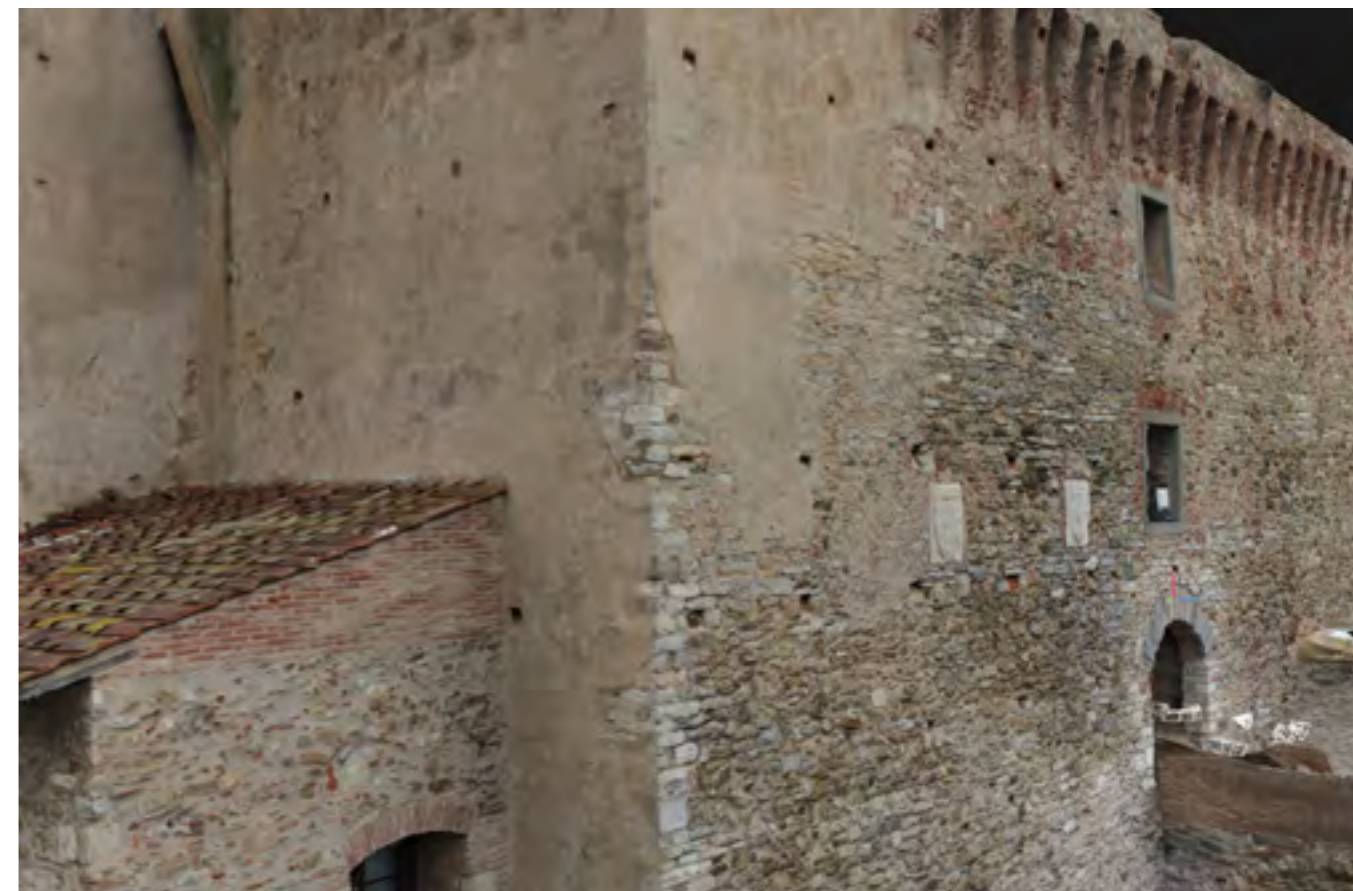
Fig. 22 Vista in proiezione prospettica del modello tridimensionale mappato fotograficamente del Castello di Piombino: si può apprezzare l'elevata qualità della texture che permette facilmente di riconoscere le tessiture murarie dei fronti del Cassero, in modo tale da facilitare le operazioni di indagine archeologica.
