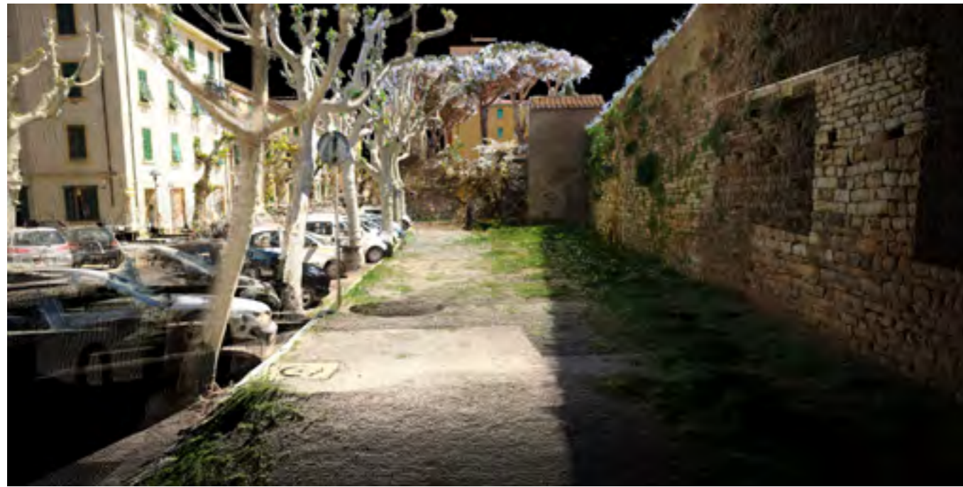
Fig. 15 Vista in proiezione prospettica della nuvola di punti, integrata di dato RGB, della porzione di cortina muraria rimasta del fronte di terra della città
