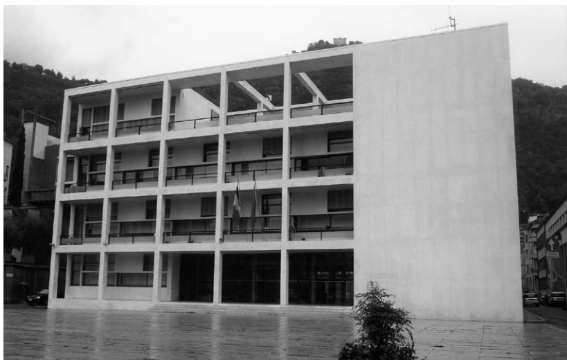
Figura 1 – Giuseppe Terragni, la Casa del Fascio, Como.
