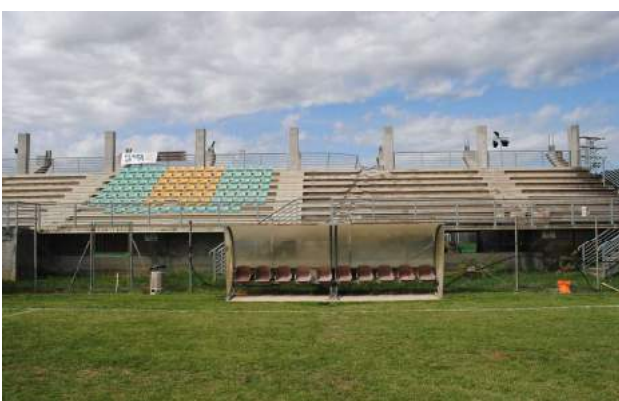
Fig. 5: particolare di un tribuna che a causa di una tempesta di vento che ha cambiato per sempre il volto degli impianti sportivo
