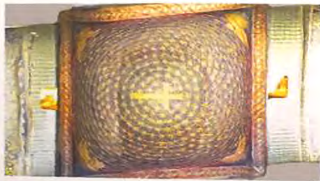
Figura 6. La proiezione ortogonale estratta dal modello mesh testurizzato acquisito tramite processo di foto-modellazione. Le stelle non appartengono a piani paralleli, ma presentano un andamento "festonato". Queste curve sono generate dall'intersezione tra i coni e la superficie della cupola (S. Giannetti).
