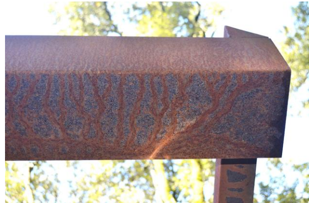
FIG.2.54: PARTICOLARE DELL'INTRADOSSO DELLA TRAVE LONGITUDINALE
