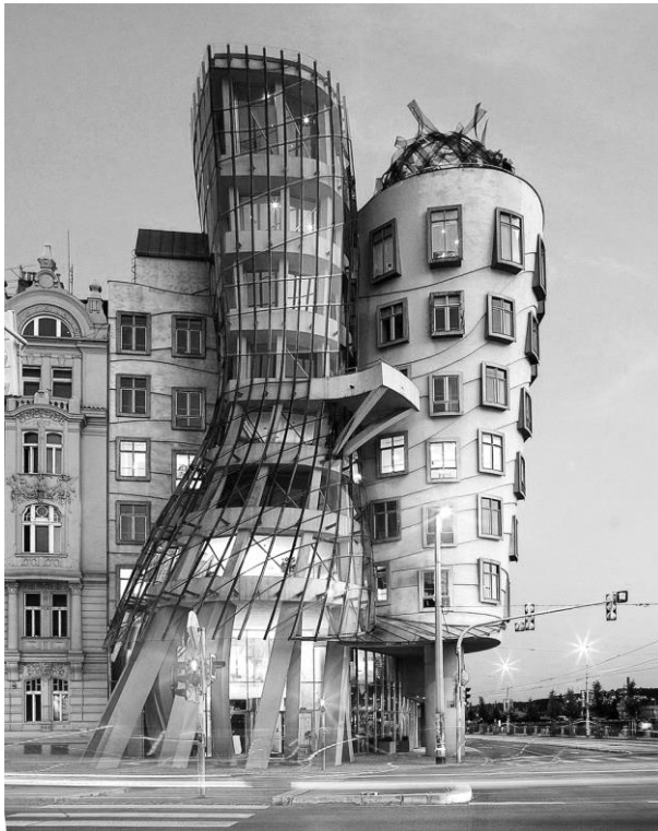
FIG.1.23: FRANK O.GEHRY, CASA DANZANTE, PARTICOLARE DELLE TORRI ANGOLARI, PRAGA, 1996
