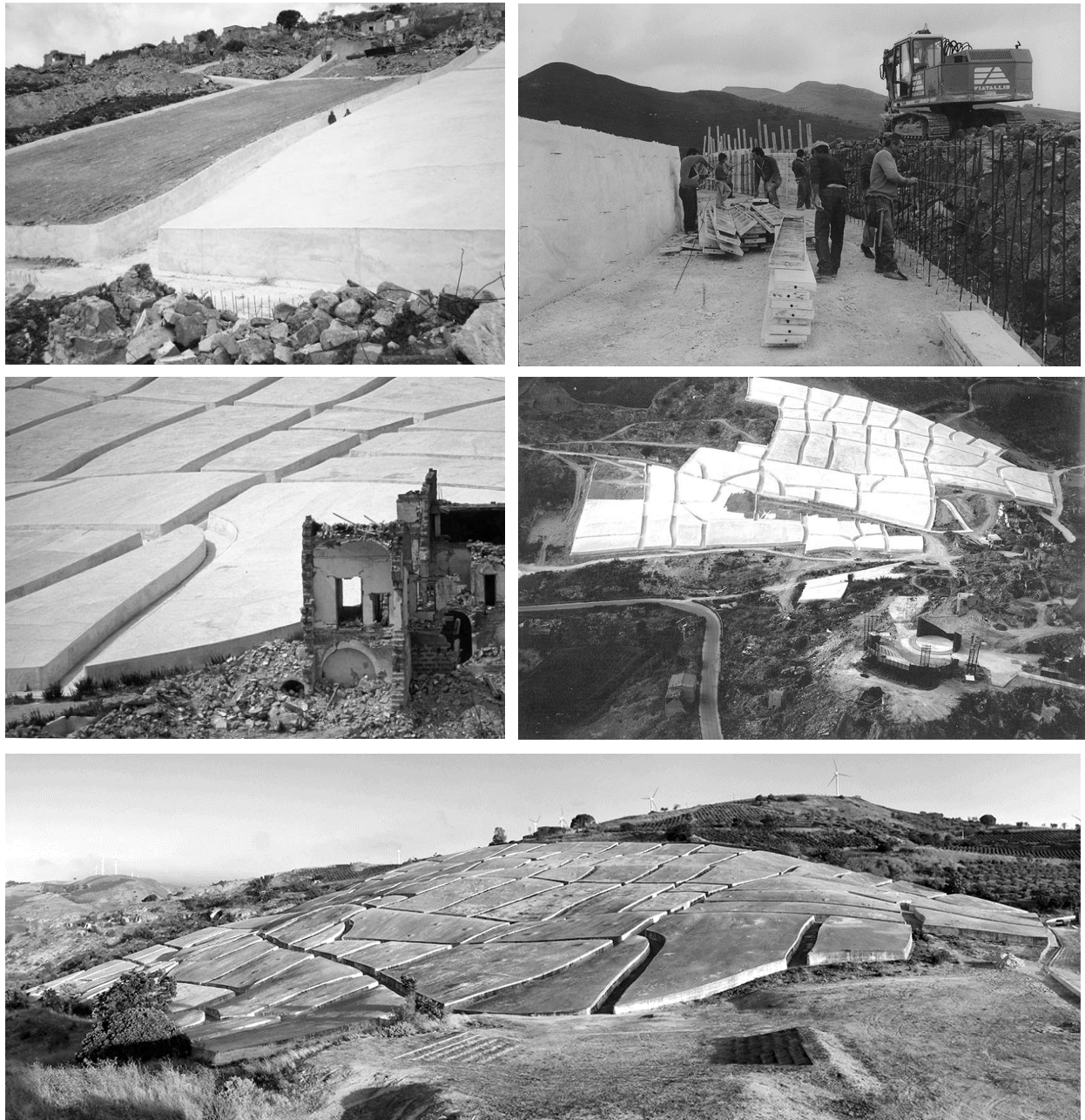
FIG.1.90: ALBERTO BURRI, I LAVORI INIZIALI AL GRANDE CRETTO, 1985
