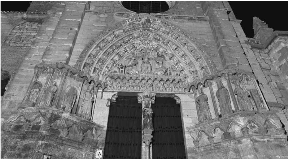
Fig. 1 Dettaglio raggiungibile della nuvola di punti; la maglia di punti è talmente densa da sembrare dato fotografico.
